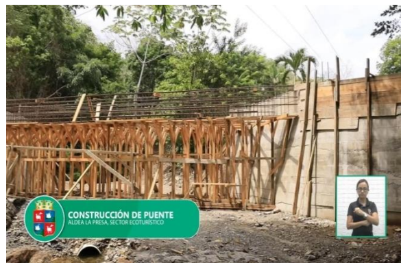
Construcción del puente la presa
