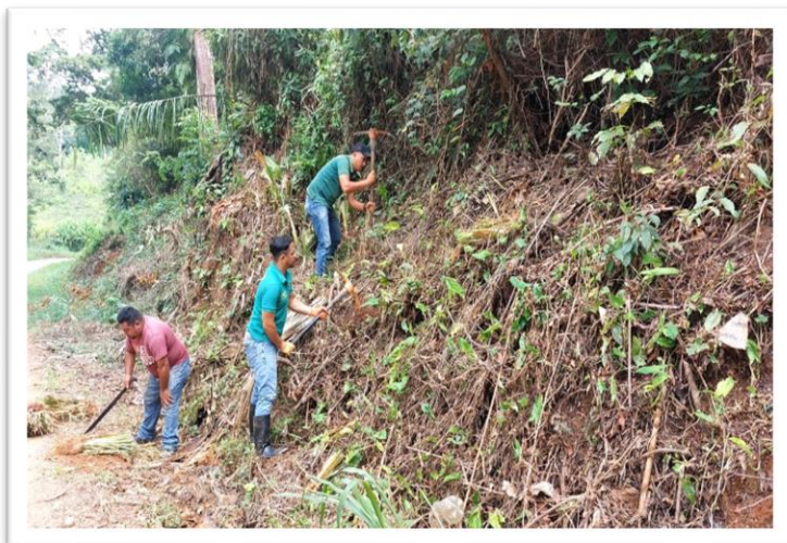
Construir barreras anti erosivas con Vetiver en aldea Las Flores
