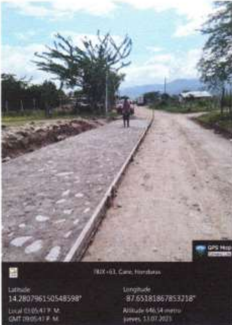
Empedrado con 15cm de espesor
