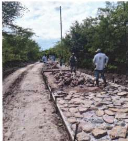
COLOCACION DE PIEDRA
