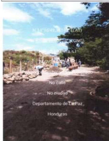
SELECCIONANDO PIEDRA, FUNDICION DEL EMPEDRADO
