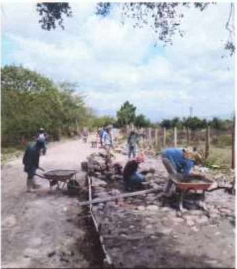
INSTALACION DE PIEDRA 15CM
