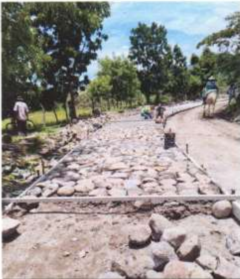
RECUBRIMIENTO DE LA PIEDRA CON CEMENTO
