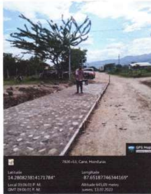
Empedrado con 15cm de espesor
