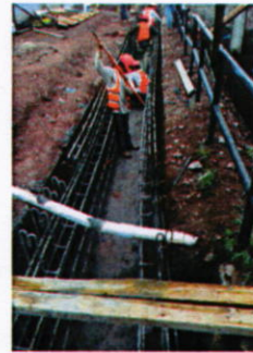
Armado y Fundido de Canal de Aguas Lluvias
