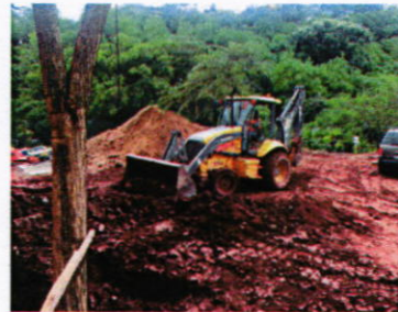
Conformación de Acceso Oeste
