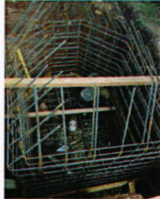
Colocación de hierro para caja eléctrica para línea de media tensión
