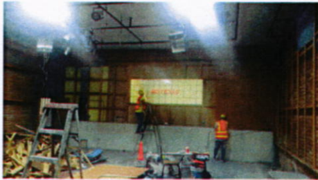
Primeras actividades, desmontaje de lo existente, paredes de panelit, ventanas de vidrio y puertas de madera y metal
