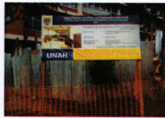
Ubicación de rótulo sobre cerco de lámina del edificio D1
