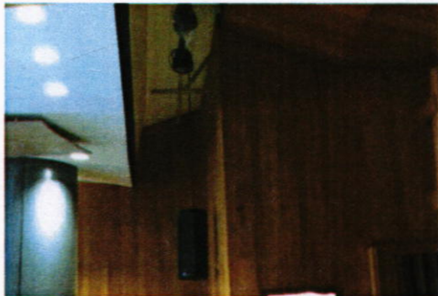
Instalación de accesorios de audio e iluminación en Auditorio.
