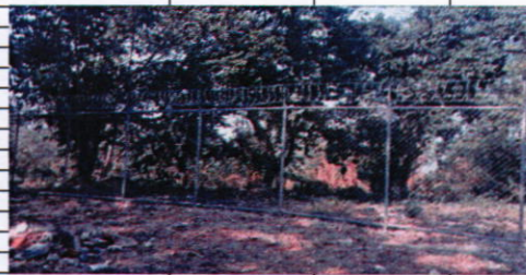
Cercos perimetral terminado terreno este
