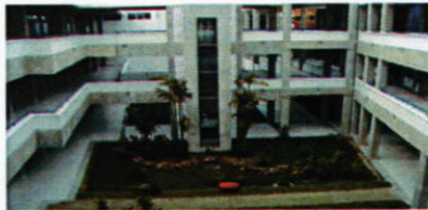
Obras exteriores e Iluminación, Módulo A
