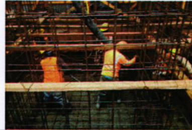
Fundición de zapata
