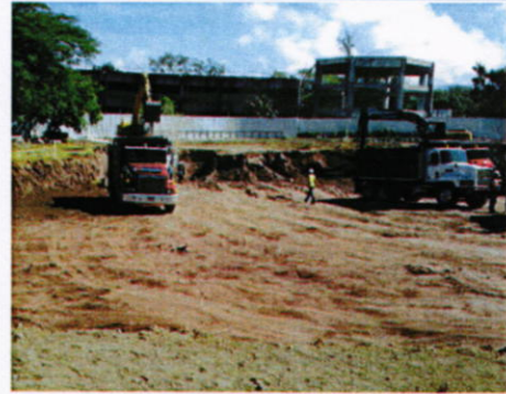
Excavación del terreno.
