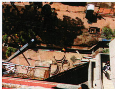
Instalación de tubería de agua potable.
