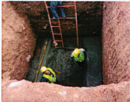
Fundición de concreto de limpieza en zapatas aisladas.
