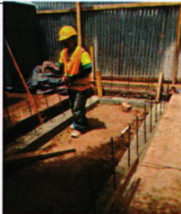
Vista fundición de solera para rampa en edificio A2
