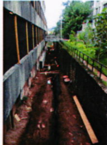
Trabajos en Sub-Drenaje y Colector de Aguas Lluvias
