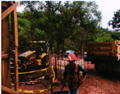
Trabajos en Exteriores de botado de desperdicios
