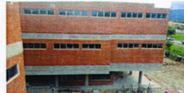
Imagen fachada norte del Módulo C
