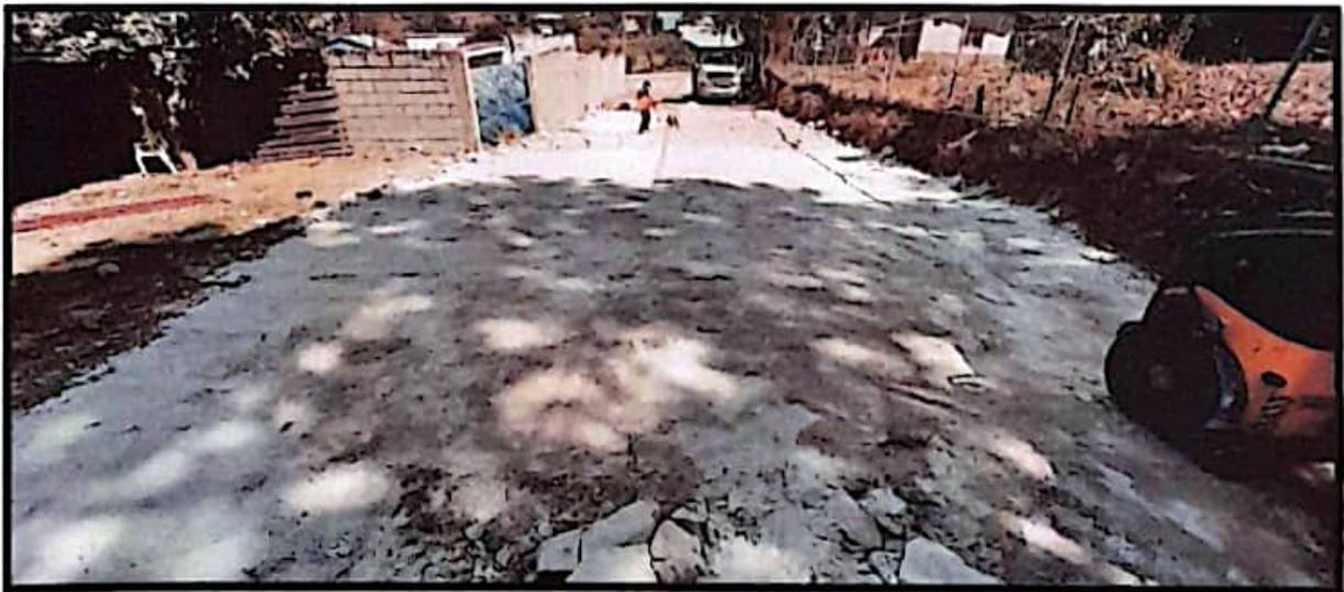
**4. Acarreo de material por desperdicio de excavación por cimentación (40% de abundamiento).**
