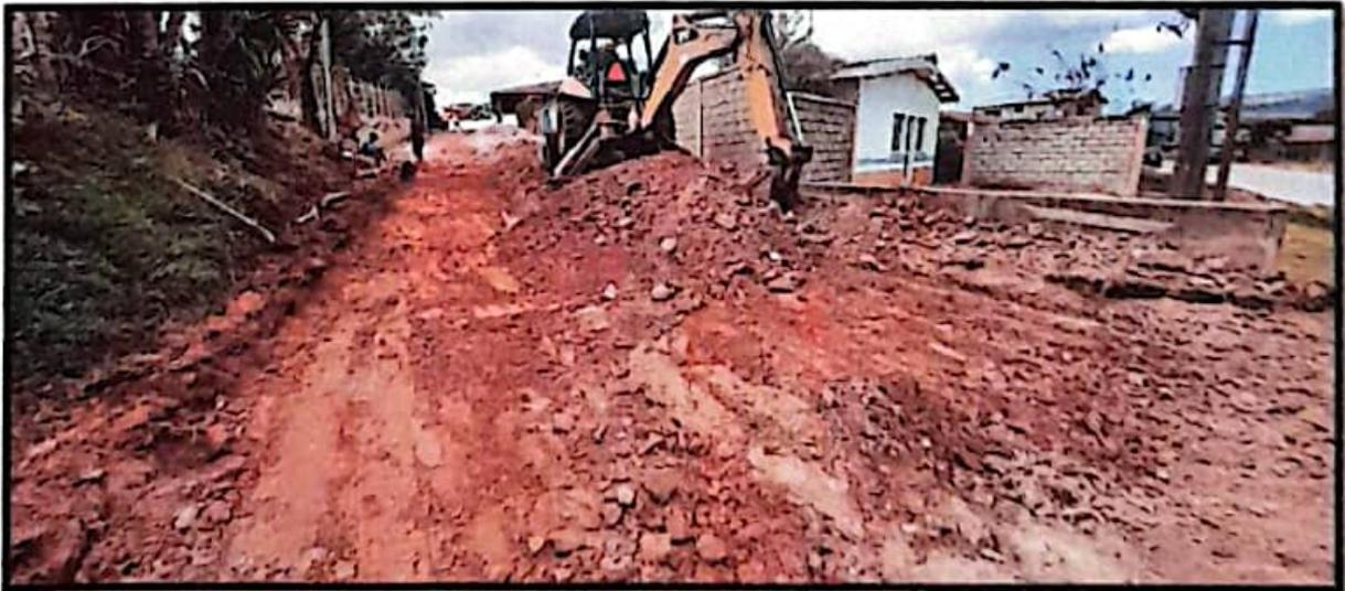
**3. Relleno y compactación de material selecto previo a la colocación firmes, pavimentos y adoquín.**
