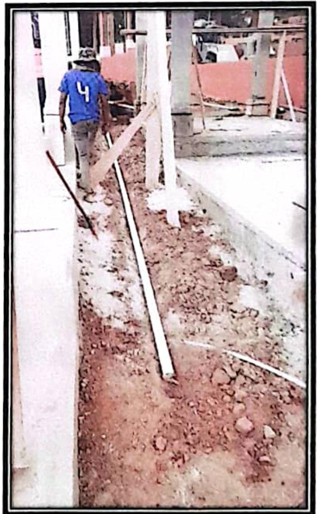
**15.: CAJA TIPO CUNETETA DE 15CMX10CM:** Excavación de caja: la cual tiene unas medidas de 10cm de profundidad tomando como referencia la pendiente del sendero, 15cm de ancho y 2.20 m de largo.
