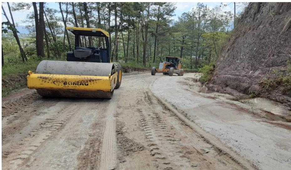
Vibro compactador y motoniveladora 670-G en trabajos de escarificado, conformación, cuneteo y vibrado de calle que conduce hacia El Orégano
