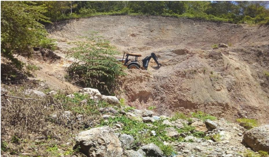
Trabajos de corte y carga de material selecto para para soterramiento de basura en el relleno sanitario
