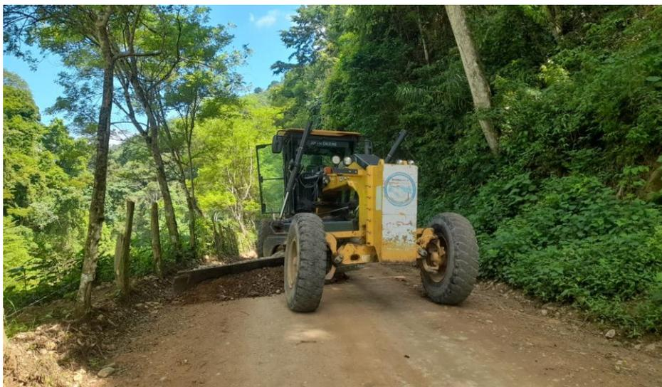
Se aprecia la maquina municipal motoniveladora 670-G y vibro compactador en trabajos de escarificado, conformación, cuneteo y vibrado de calle que conduce de la aldea El Zanjón hacia la aldea Chalmeca
