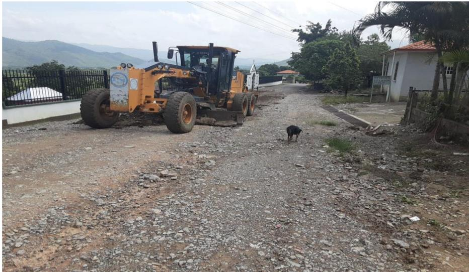
Se visualiza la maquina municipal en trabajos de escarificado, conformación, cuneteo y vibrado de calles en la aldea Chalmeca
