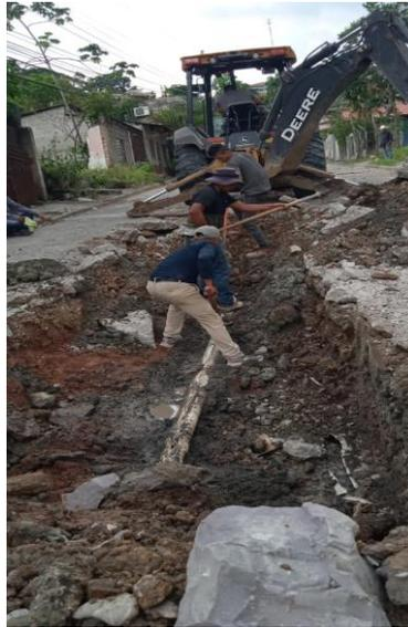
Trabajos de apoyo al personal de Aguas de La Entrada en demolición de losa para posteriormente escalación para reparación de tubería de aguas residuales en el barrio El Progreso
