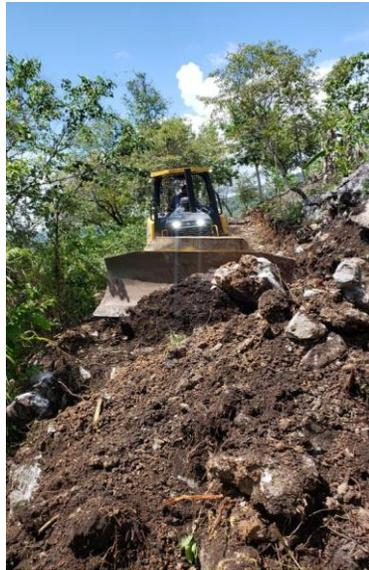
Se visualiza la apertura y ampliación de calles en la aldea Quebrada Seca con la máquina municipal bulldozer sobre orugas 750II-J
