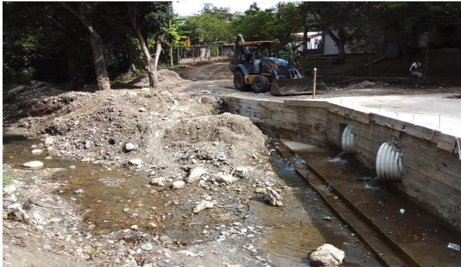
Retroexcavadora 310-L en trabajos de dragado de quebrada Negra sobre vado mixto ubicado ingresando de la aldea Santa Luz hacia el caserío El Borbollón
