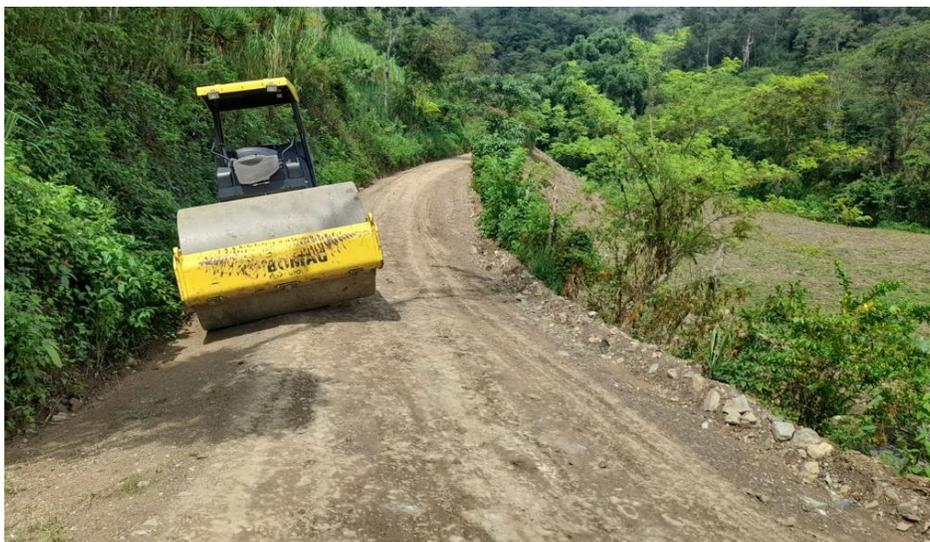
Máquina vibro compactador y motoniveladora 670-G en trabajos de escarificado, conformación, cuneteo y vibrado de calles en la aldea El Zanjón
