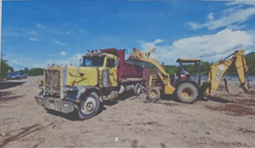
*Ilustración 1.* Volqueta siendo cargada por Retroexcavadora, en banco de prestamos sector de la puntilla, Nacaome Valle, 11/07/2022.
