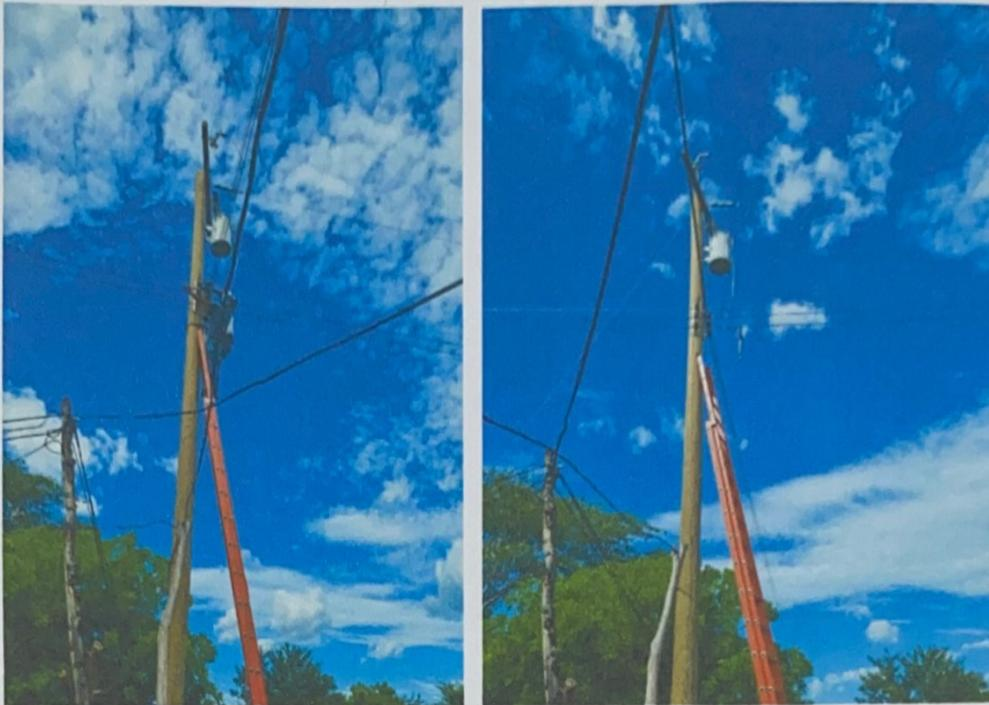
14. Conexión de transformador para el para rayo con cable de cobre #2.
