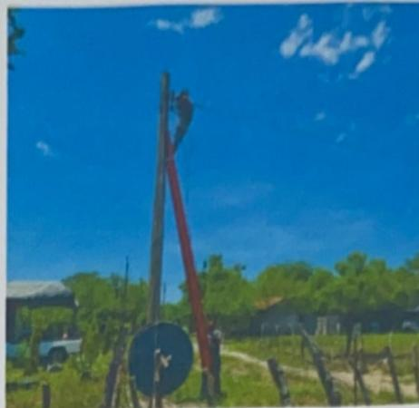
9. Instalación de cuchilla rompe arco en el poste de 40 pie donde va el transformador 15 KVA y en el poste de 35 pie que está en la calle principal a la orilla del campo de futbol del tular abajo, con una cuadrilla 6 personas
