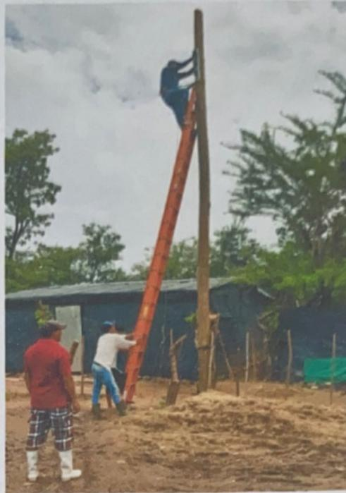
5. Vestimenta de poste de 40 pies para el cable primario, el tipo de estructura A-1,2 A-1,4, con una cuadrilla de 13 personas.
