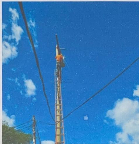
13. Conexión de transformador al cable secundario con cable 1/0, con una cuadrilla
