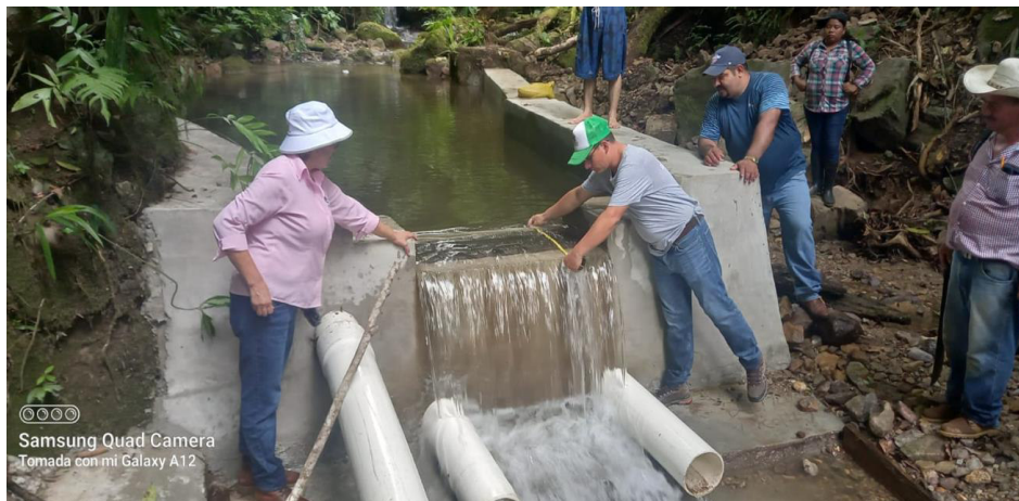
Aforo en el vertedor de la obra de captación
