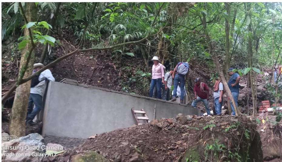
Desarenador construido aguas debajo de la obra de captación
