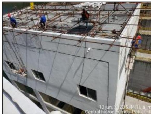
**Escarificado de junta entre marco rígido y paredes de bloque lateral derecha y aguas abajo en cuarto de operación de descarga de fondo.**
