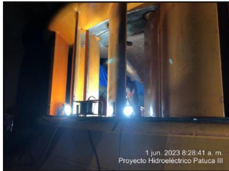
Ilustración 1: Trabajos de Soldadura y pulido de álabes móviles de Unidad Espiral No. 1.
