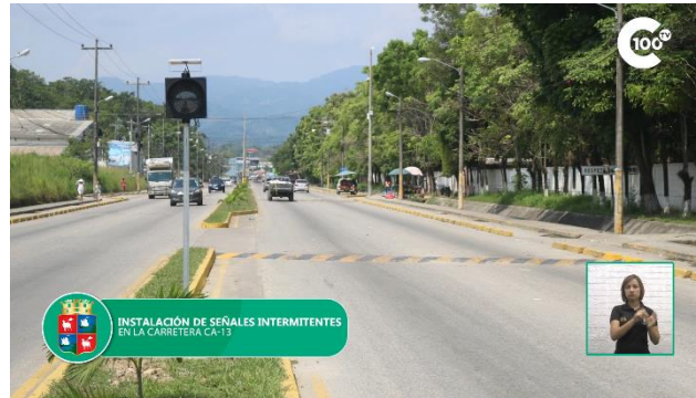
Instalación de señales de tránsito
