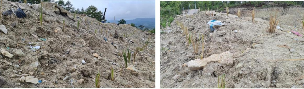
*Figure 18 Estabilización de talud de relleno, celdas 1, 2 y 3.*
