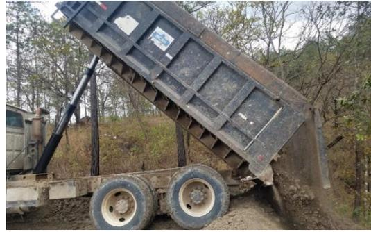
*Figure 12 Evacuación de Material de desperdicio*
