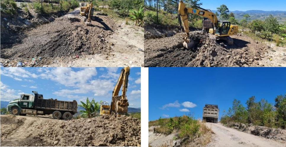
*Figure 33 Extracción de capa vegetal y acarreo de desperdicio*
