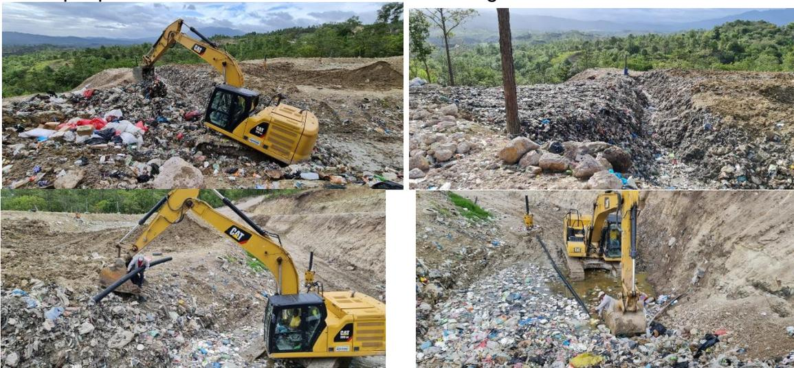
*Figure 22 Alivio de fluidos estancados con instalación de drenaje superior*
