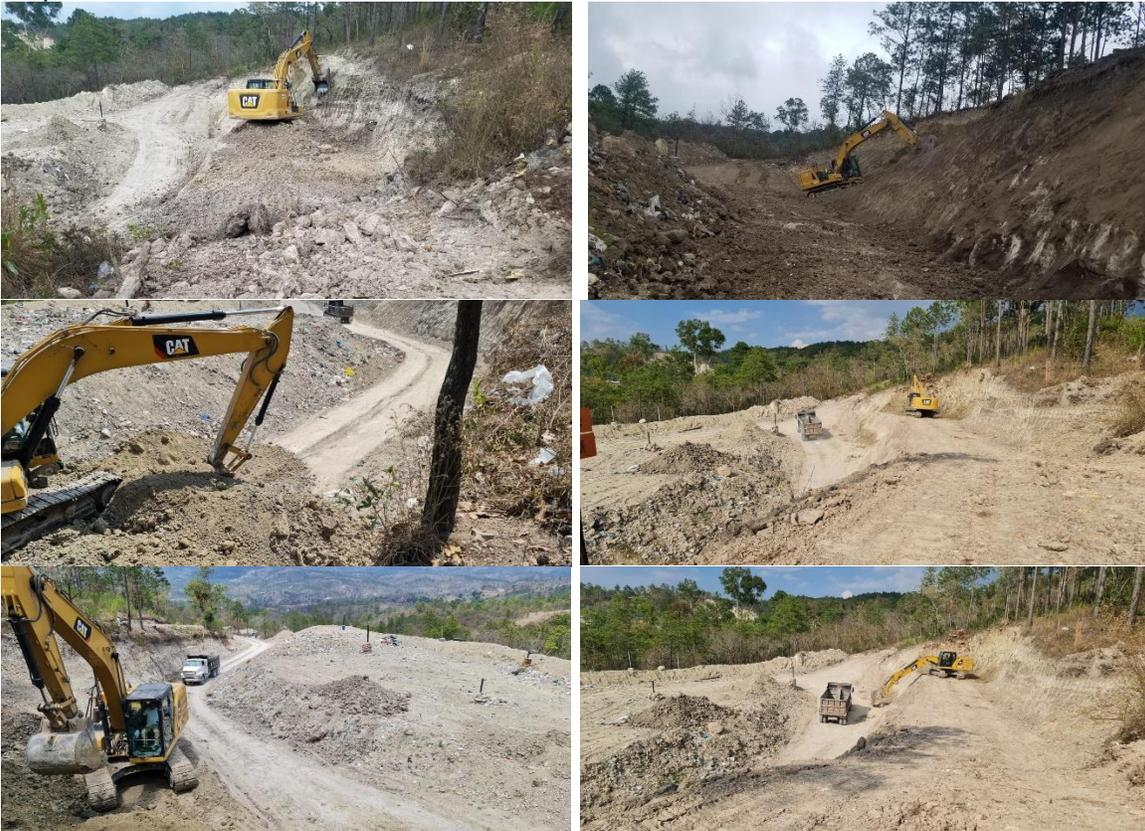
*Figure 10 Corte de Talud, ampliación y acarreo*
