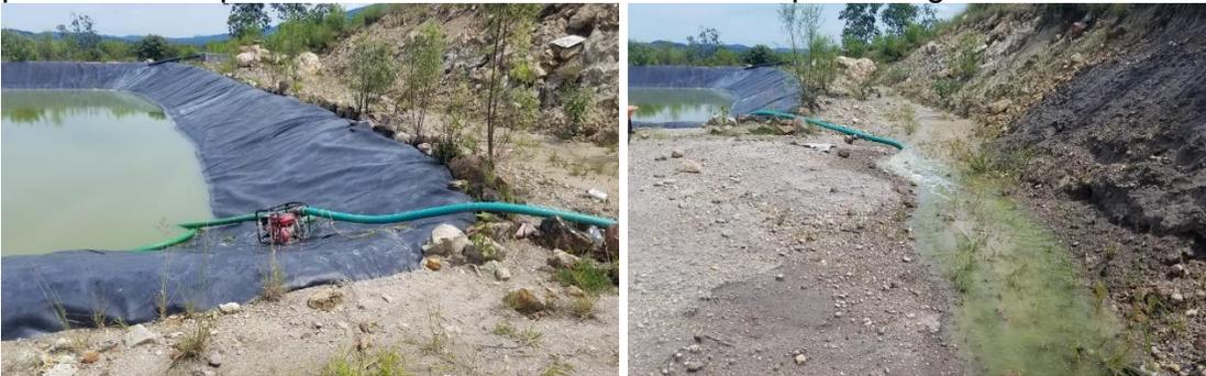
*Figure 24 Descarga realizada con bomba achicadora 3"*
