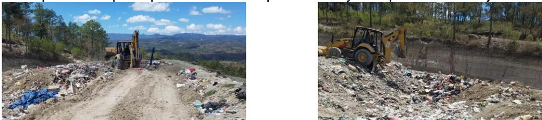
*Figure 19 Cobertura haciendo uso de retroexcavadora.*
