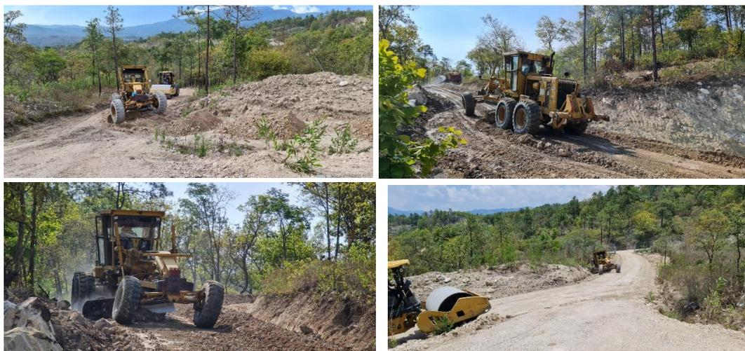
*Figure 15 Regado con Motoniveladora, compactado con rodillo*
