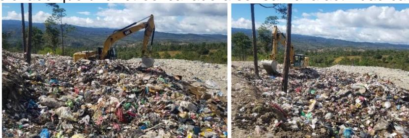
*Figure 27 Recogida y compactado*
