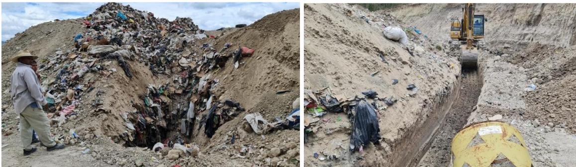
Figure 4 Construcción de filtro
