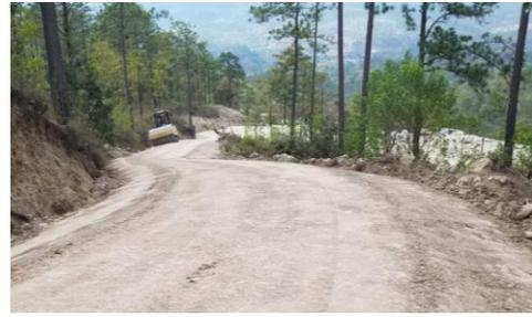
*Figure 17 Etapa final de conformación tipo 1*
