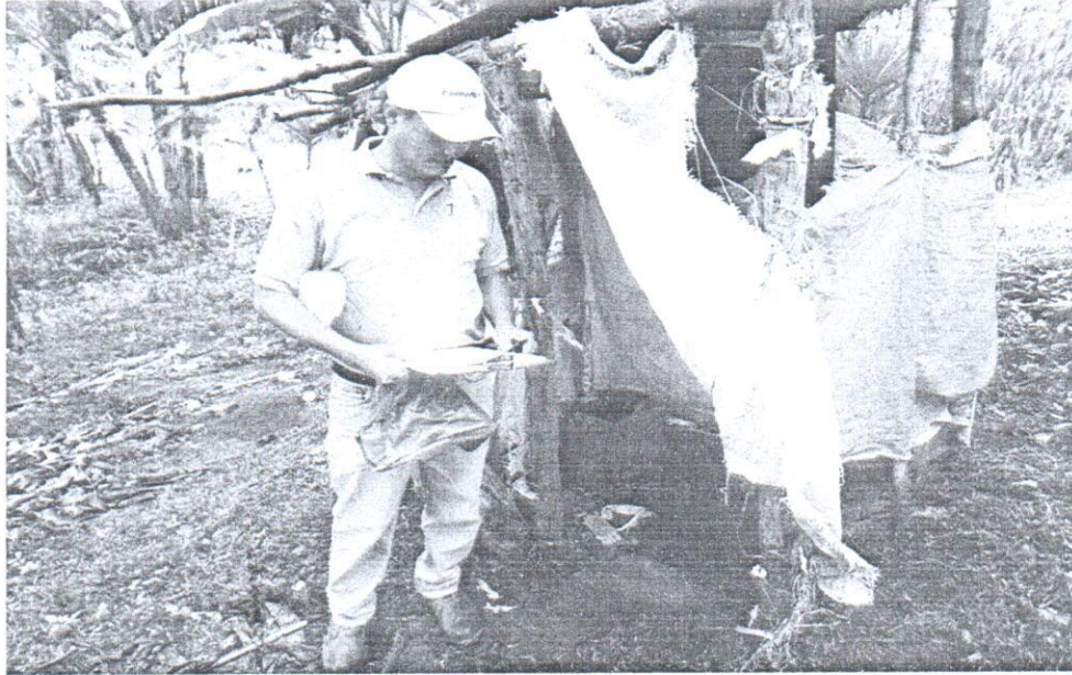
Fotografía No.1: Situación de las letrinas en mal estado
