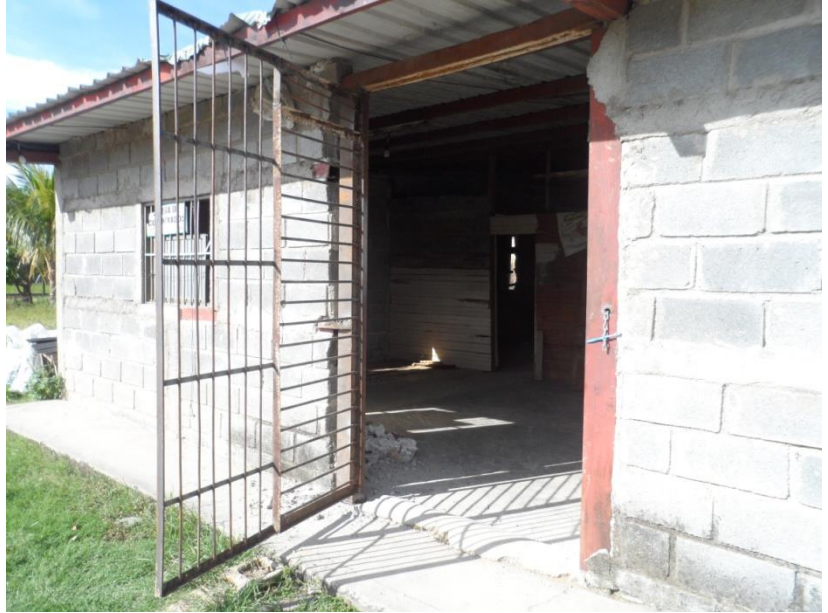
Colocación de puerta en bodega de concentrados
