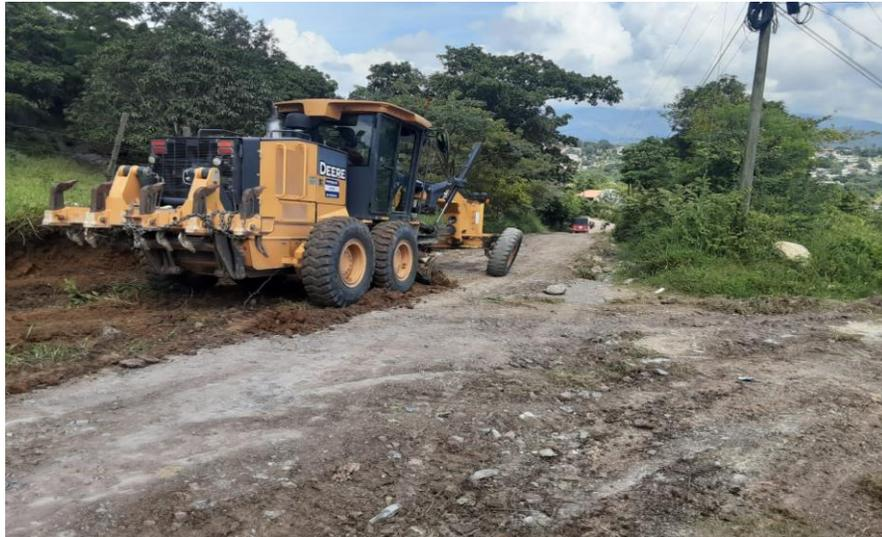
Se observa la maquina motoniveladora 670G en trabajos de escarificado, conformación cuneteo en calle que conduce del barrio Suyapa hacia aldea Los Pozos.
