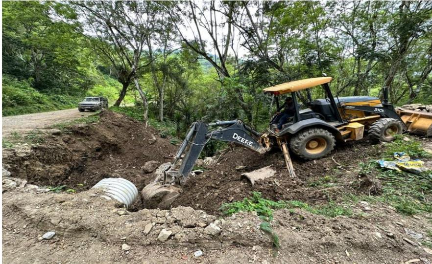
Se observa la máquina retroexcavadora 310 L en trabajos de limpieza de alcantarillados.
