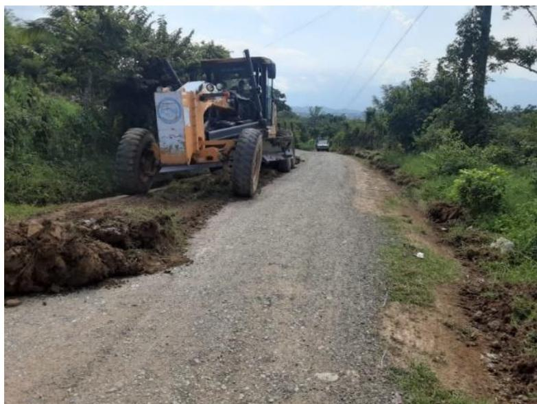
Se aprecia la maquina municipal Motoniveladora 670-G en trabajos de escarificado, conformación, cuneteo y vibrado en calles en la aldea Quebrada Seca hacia Santa Luz.
