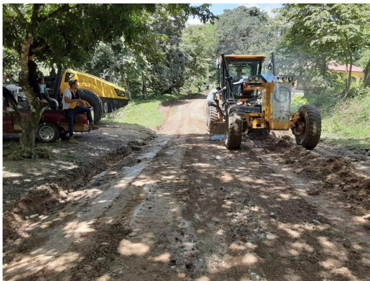
Trabajos de escarificado de conformación, cuneteo y vibrado de desvío que conduce hacia la aldea Nueva Arcadia.
