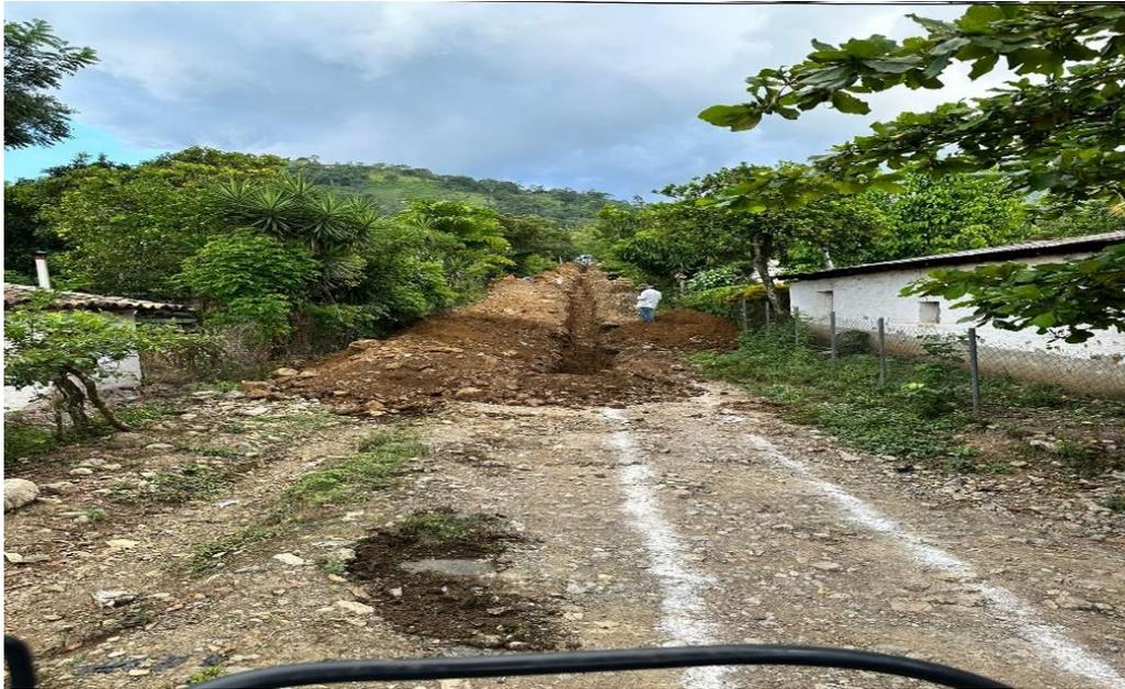
Se aprecia la excavación para instalación de tubería para alcantarillado en aldea de Quebrada Seca.
