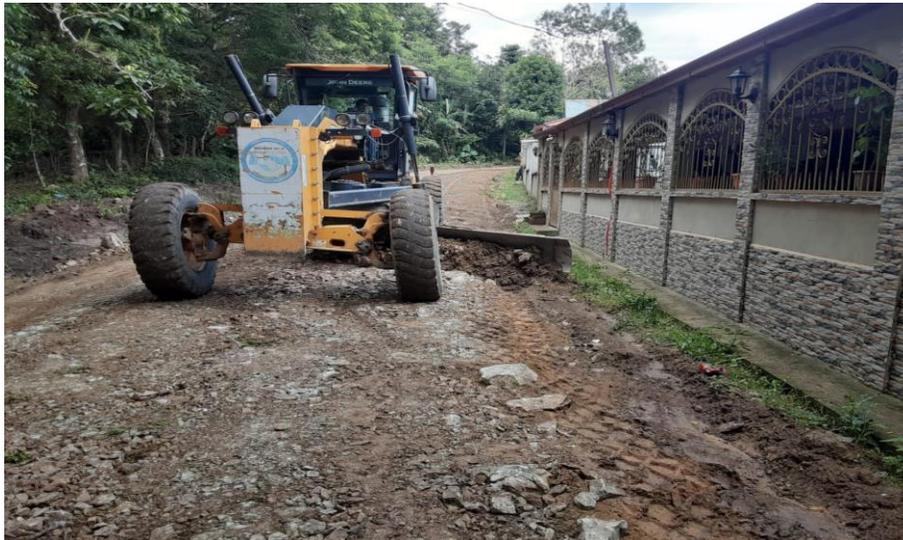
Se visualiza la máquina MOTONIVELADORA 670-G en trabajos de escarificado, conformación y cuneteo en las calles de la aldea de Nueva Arcadia.
