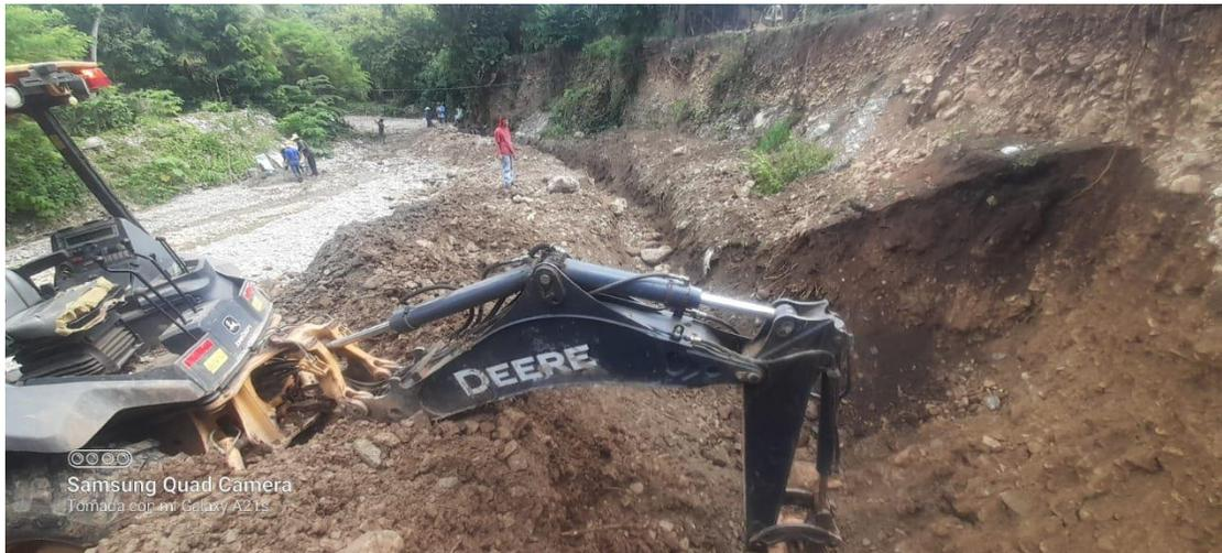
Trabajos de excavación para la construcción de muro de contención en quebrada de Chalmeca.
