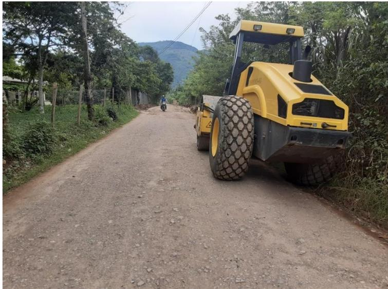
Vibro Compactador en trabajos de vibrado de calle que conduce de la aldea Santa Luz hacia la ciudad de La Entrada
