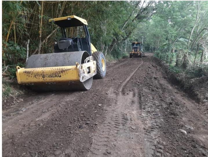
Se aprecia la maquinaria municipal en la conformación y vibrado de la carretera en la comunidad de Saisoque
