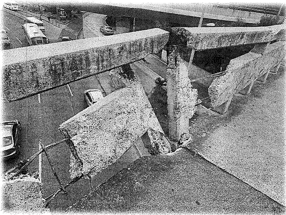
Imagen representativa de las reparaciones a realizar en distintos pretiles de concreto
