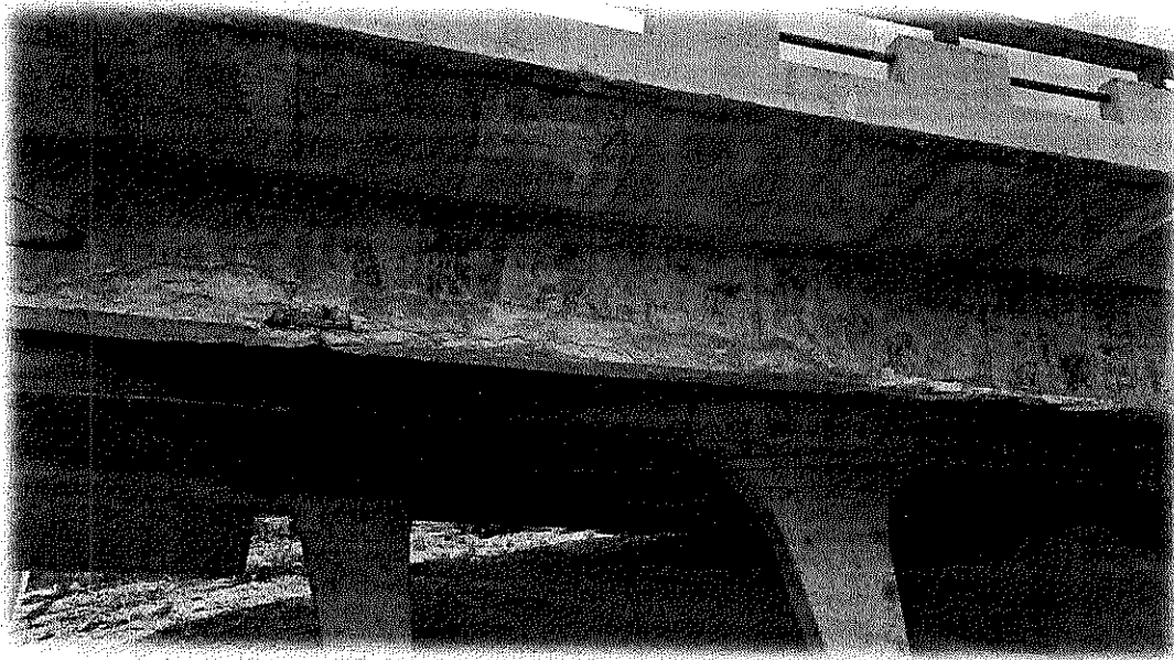
Imagen representativa de la necesidad de resanes en vigas de algunos pasos a desnivel
