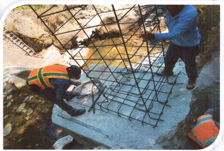
**RESULTADO;** se procedio a la colocacion del hierro para la fundicion de las zapatas y de las columnas, el armado se hizo con varilla de 1/2" y de 3/8".
