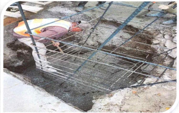
**DESCRIPCION:** Se realizo la fundicion de las zapatas aisladas y de las columnas de soporte del puente metalico.
