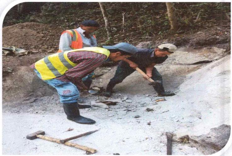
**RESULTADO;** Se procedio a la excavacion para la colocacion del armado de las zapatas aisladas, la excavacion es en suelo tipo roca lo que dificulta la labor del contratista.
