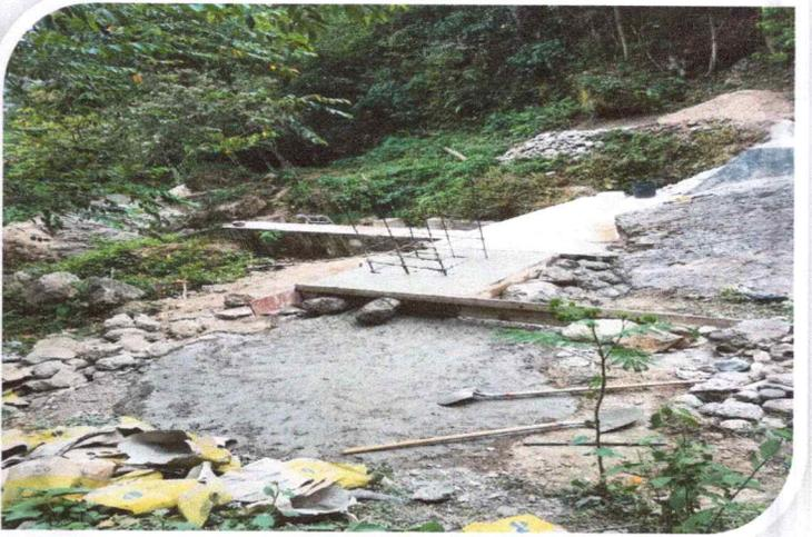
RESULTADO; Las zapatas tienen una dimension de 1.5x1.50x0.60 de espesor y las columnas son de 1.10x1.10 con 6 varillas de 1/2" y varilla de 3/8" a/c 20.00 cms. Solo quedo a la espera en la parte superior para realizar la fundicion del puente monoliticamente con la parte faltante de la columna.
