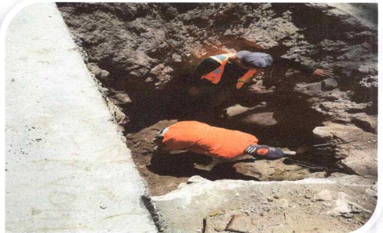
**DESCRIPCION:** Para mejorar la limpieza de las rejilla central y lateral se decidió colocar un puente metalico en el Rio Danto para hacer esto se requiere la excavacion para la colocacion de zapatas aisladas y columnas donde iran soportado el puente.
