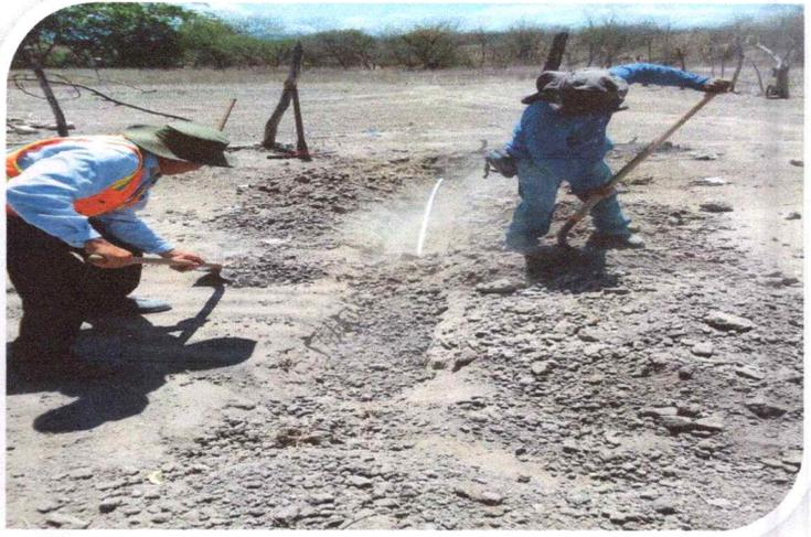
**RESULTADO;** La excavacion se hizo de manera manual con personal, dicha tuberia se coloco para hacer la instalacion de 4 pegues completamente nuevos en el sector.
