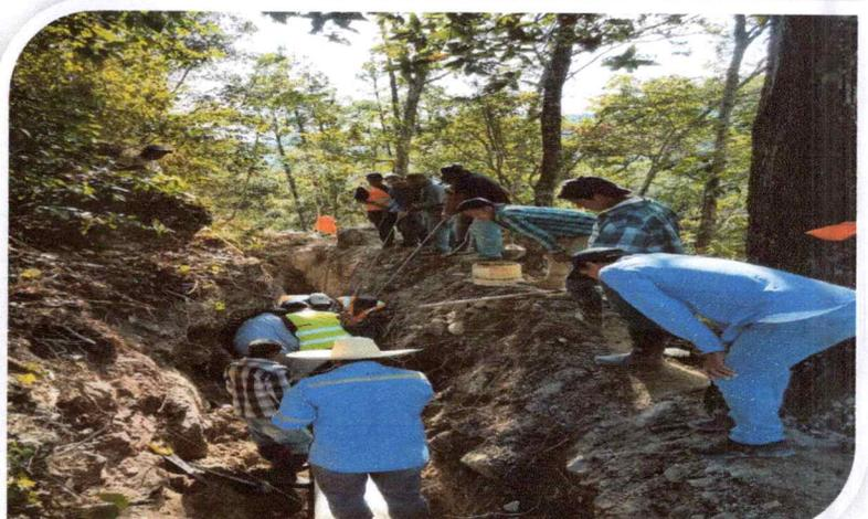
**DESCRIPCION:** Se presentó un daño en la tubería PVC de 12" en La Línea de conducción principal el día Jueves santo por lo que fue necesario realizar la reparación del tramo para abastecer de agua a las comunidades, se contrato personal adicional para realizar las labores lo mas rápido posible.
