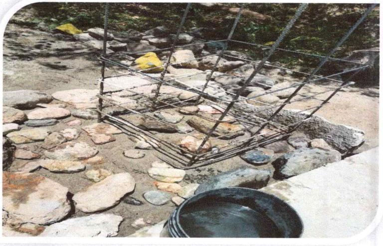
**RESULTADO;** Las zapatas tienen una dimension de 1.5x1.50x0.60 de espesor y las columnas son de 1.10x1.10 con 6 varillas de 1/2" y varilla de 3/8" a/c 20.00 cms.
