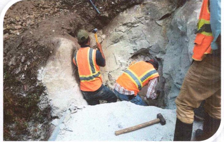
**DESCRIPCION:** Para mejorar la limpieza de las rejilla central y lateral se decidió colocar un puente metalico en el Rio Danto para hacer esto se requiere la excavacion para la colocacion de zapatas aisladas y columnas donde iran soportado el puente.
