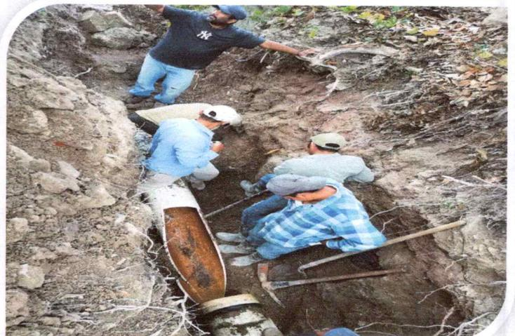
**RESULTADO;** El daño se presentó en una campana de la tubería PVC 12" por lo que fue necesario realizar la excavación para poder encontrar el daño, las excavaciones tenían una profundidad de 1.60 metros.
