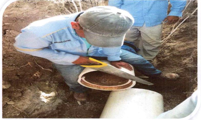
**DESCRIPCION:** El daño se presentó en una union de una tubería con la otra ( campana ) por lo que el agua se estaba botando en este sector.
