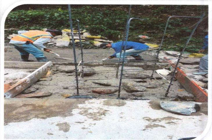
DESCRIPCION: Se realizo la fundicion de las zapatas aisladas y de las columnas de soporte del puente metalico.
