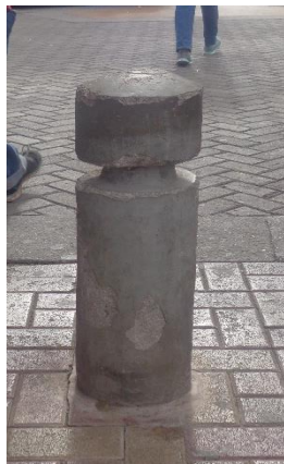
Imagen: Detalle de Bolardo de concreto armado
