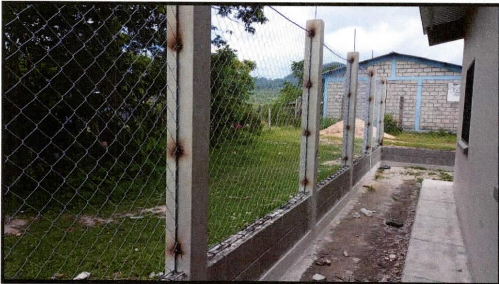
**5. Se esta instalando malla ciclón, se observa columnas y pared de bloque.**
