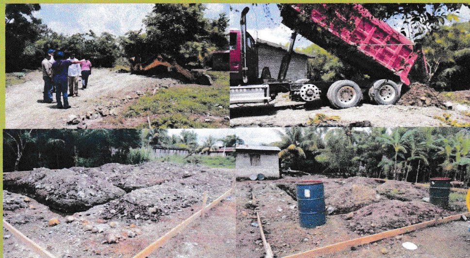
Supervisión de gerencia técnica municipal junto con el personal de medicusmundi Bizkaia, en la Construcción de Centro de Acopio y Oficina de la Asociación de Juntas de Agua y Saneamiento
