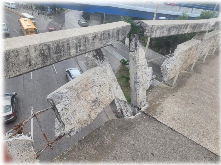
Imagen representativa de las reparaciones a realizar en distintos pretilos de concreto
