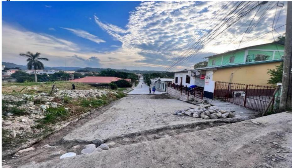
Se aprecia el avance de obras en el proyecto Mantenimiento y reparación de calles pavimentadas en barrios y colonias de esta ciudad / Reparación de calle con concreto ciclópeo y whitetopping unión del barrio El Progreso con barrio El Triángulo
