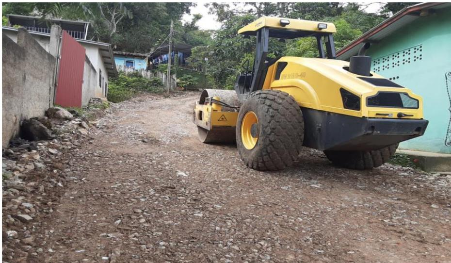
Vibro compactador y motoniveladora 670-G en trabajos de escarificado, conformación, cuneteo y vibrado de calle que conduce de la aldea Chalmeca hacia caserío El Limón.
