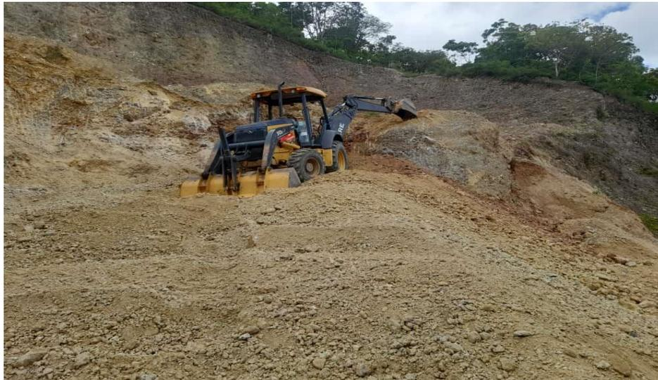
Se aprecia la maquina municipal retroexcavadora 310-L en trabajos de corte y carga de material selecto para balastado de calles en la aldea Chalmeca
