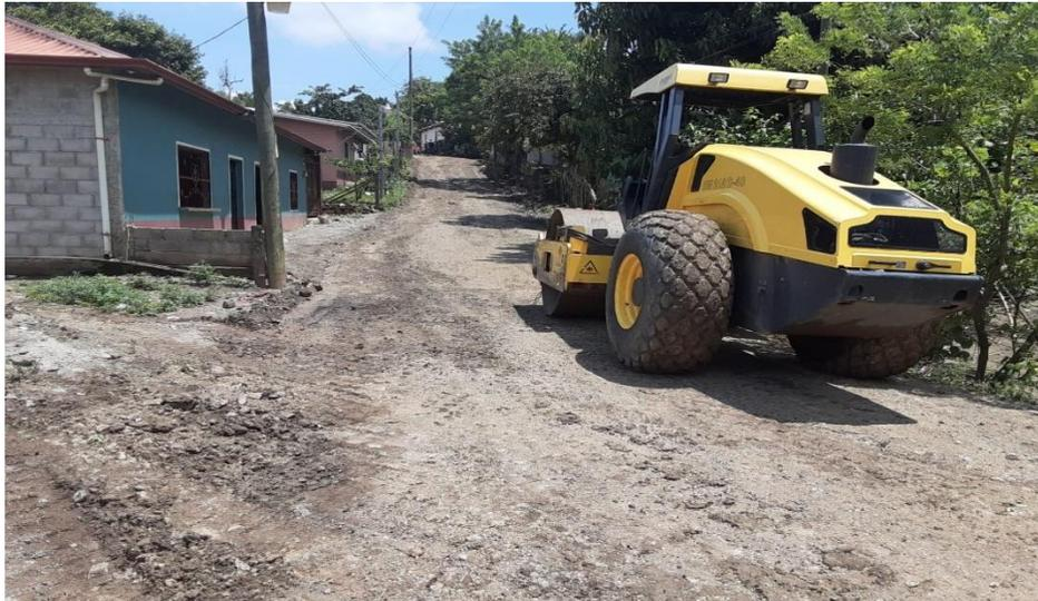
Maquinaria municipal en trabajos de escarificado, conformación, cuneteo y vibrado de calle que conduce de la aldea Quebrada Seca hacia la aldea Santa Luz.
