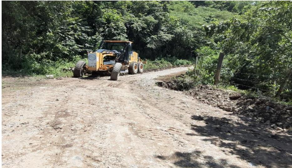
Trabajos de escarificado, conformación, cuneteo y vibrado de calle que conduce de la aldea Chalmecca hacia el caserío Comederos.
