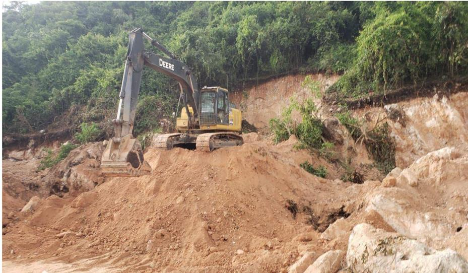
Excavadora 210-G en trabajos de corte y carga de material selecto para soterramiento de basura en relleno sanitario ubicado en el barrio Bella Vista 2
