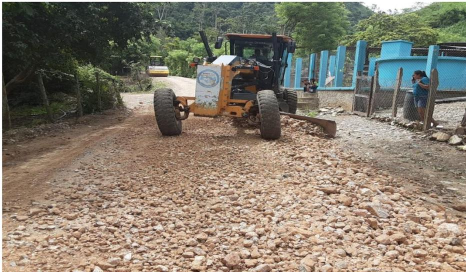
Se visualiza la máquina motoniveladora 670-G y vibro compactador en trabajos de escarificado, conformación, cuneteo y vibrado de calles en la aldea Chalmeca.
