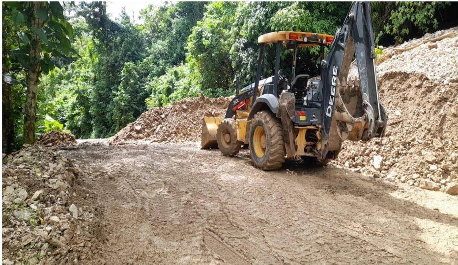
Se visualiza la máquina Retroexcavadora 310-L en trabajos de limpieza de calle a causa de derrumbos tramo que conduce de la aldea Chalmeca hacia la aldea El Zanjón.
