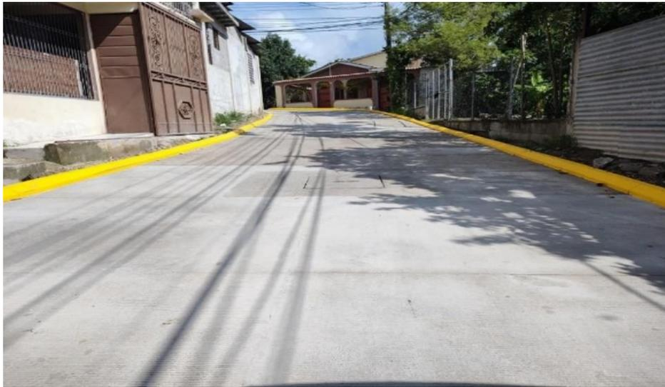
Trabajos finalización de losa de concreto hidráulico en el proyecto de reconstrucción de calle frente a Hermis Pineda, barrio Miraflores, La Entrada, Nueva Arcadia, Copán.
