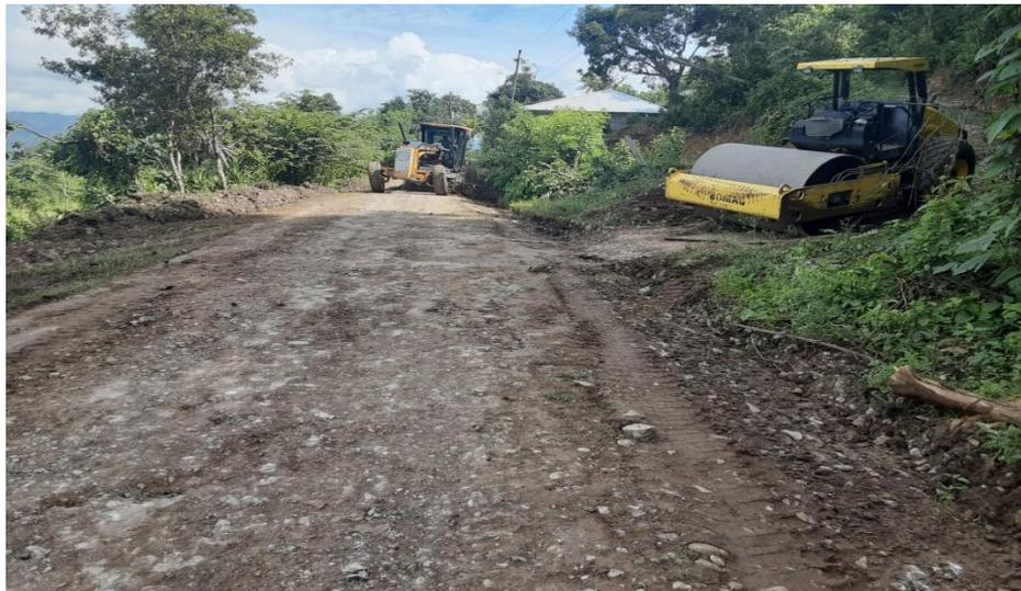
Trabajos de escarificado, conformación, cuneteo y vibrado de calle que conduce de la aldea Chalmecca hacia caserío Nueva Ceibita
