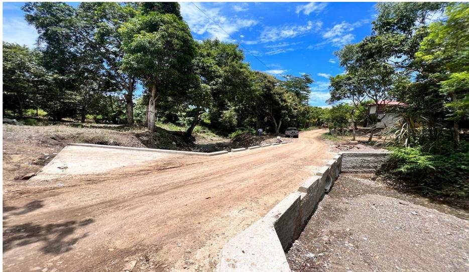
Se aprecia la finalización del proyecto Construcción de vado sobre quebrada Negra, acceso a caserío El Borbollón.
