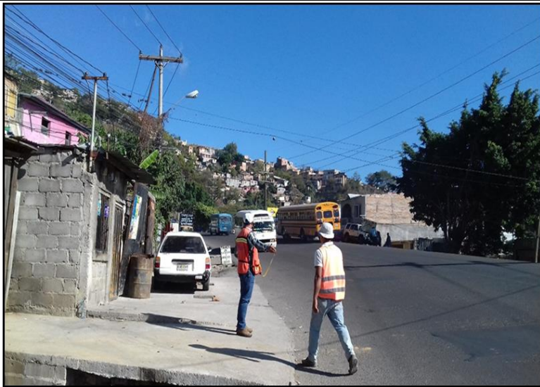
No.6 Actividad: imágenes representativas del estado de la red vial en los diferentes Distritos del Municipio Central Proyecto: "REHABILITACION DE LA RED VIAL URBANA EN EL M.D.C: PROGRAMA 2023" Fecha: 09/02/2023
