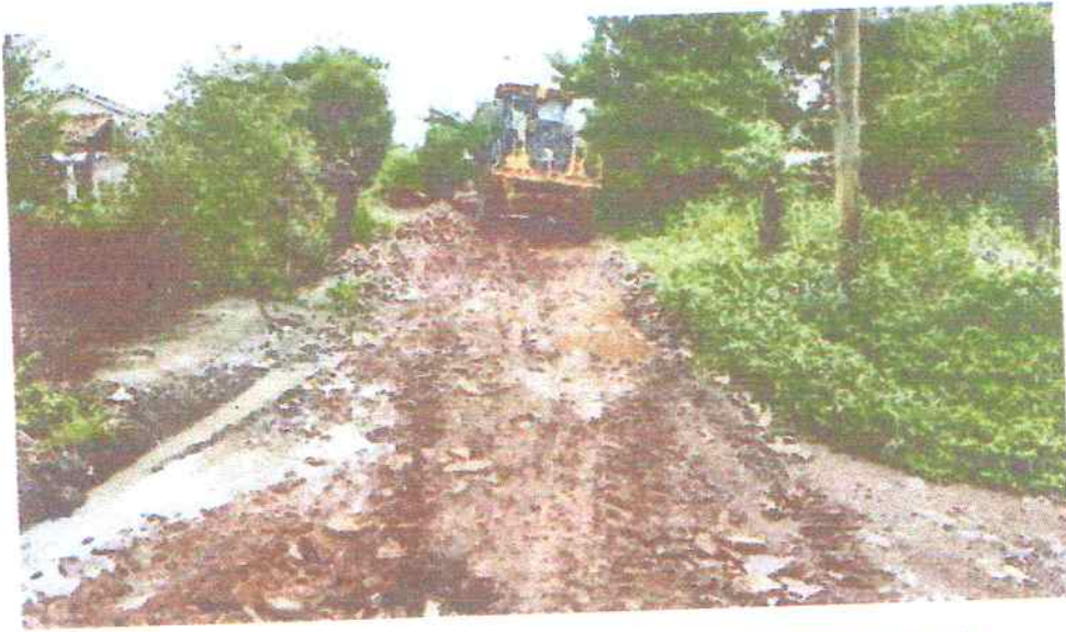
Ilustración 1. Conformación de calle y balastreo en la comunidad de playa grande, Nacaome, Valle
