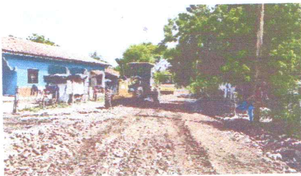
Ilustración 4. Conformación de calle y balastreo en la comunidad de agua fría, Nacaome, Valle.
