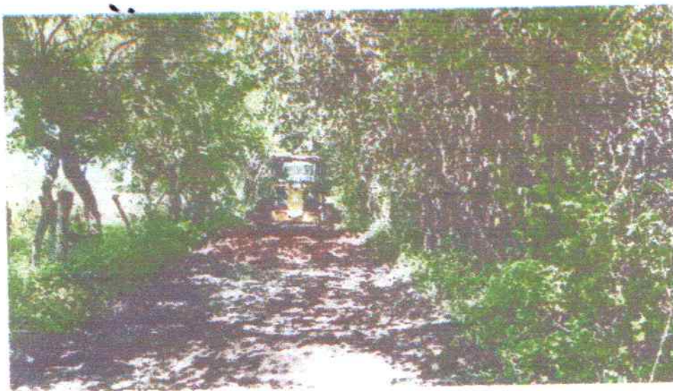
Ilustración 3. Conformación de calle y balastreo en la comunidad La montaña, Nacaome Valle.
