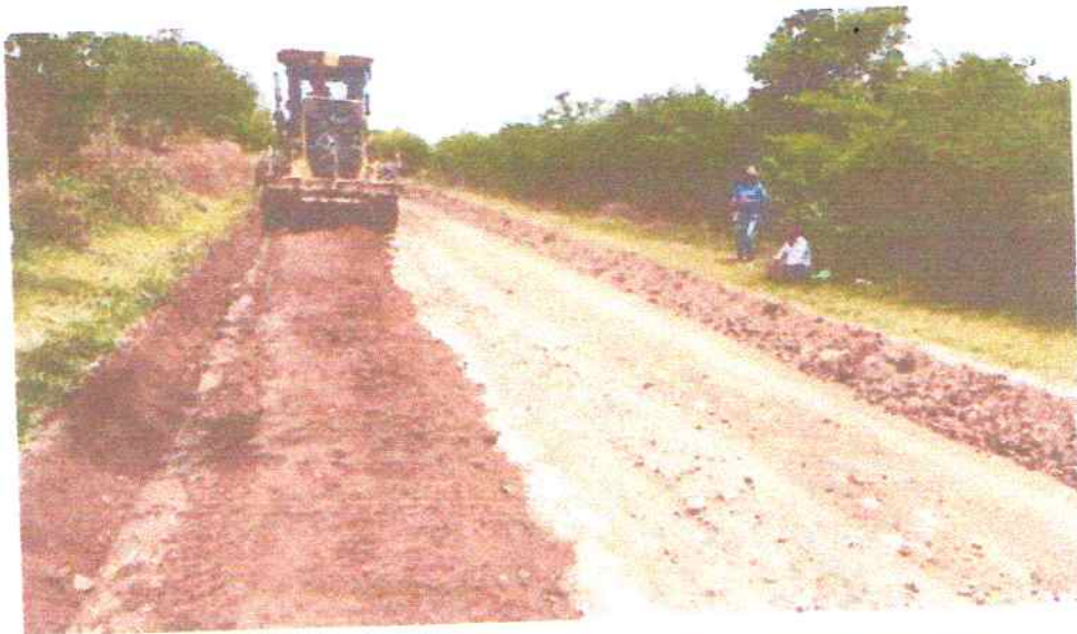
Ilustración 2. Conformación de calle y balastreo en la comunidad de playa grande, Nacaome, Valle
