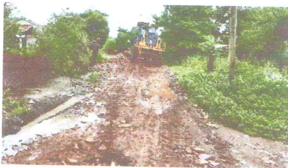
Ilustración 1. Conformación de calle y balastreo en la comunidad de playa grande, Nacaome, Valle
