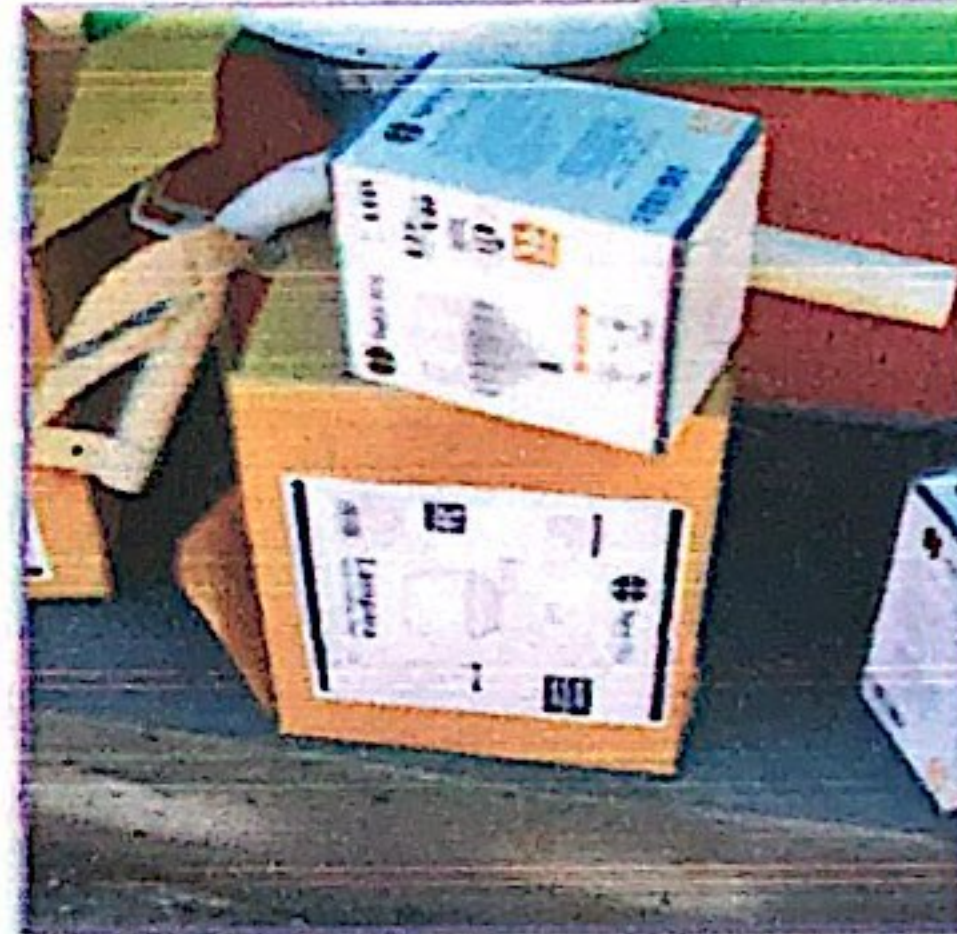
Materiales recibidos para reparación y extensión de línea secundaria
