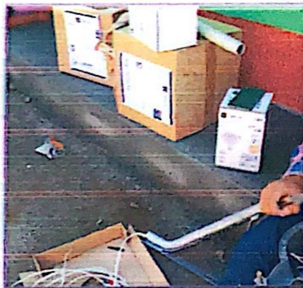
Materiales recibidos para reparación y extensión de línea secundaria
