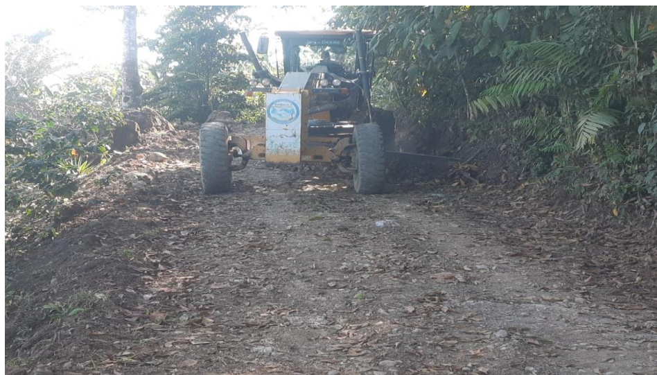
Maquinaria municipal en trabajos de escarificado, conformación cuneteo y vibrado de calle que conduce de la aldea Quebrada Seca hacia la aldea San Diego
