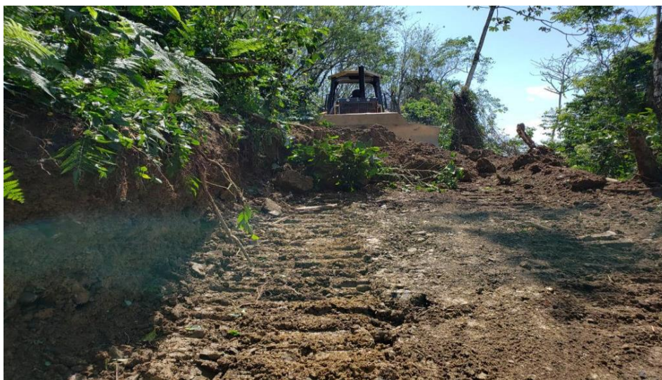
Maquina municipal en trabajos de apertura de calle en la aldea La Cuchilla Zapa
