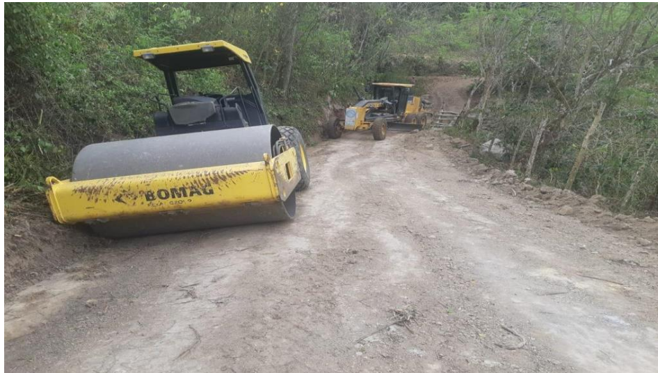
Maquinaria municipal en trabajos de escarificado, conformación cuneteo y vibrado de calle que conduce de la aldea San Pablo del Roble hacia Sector La Zona
