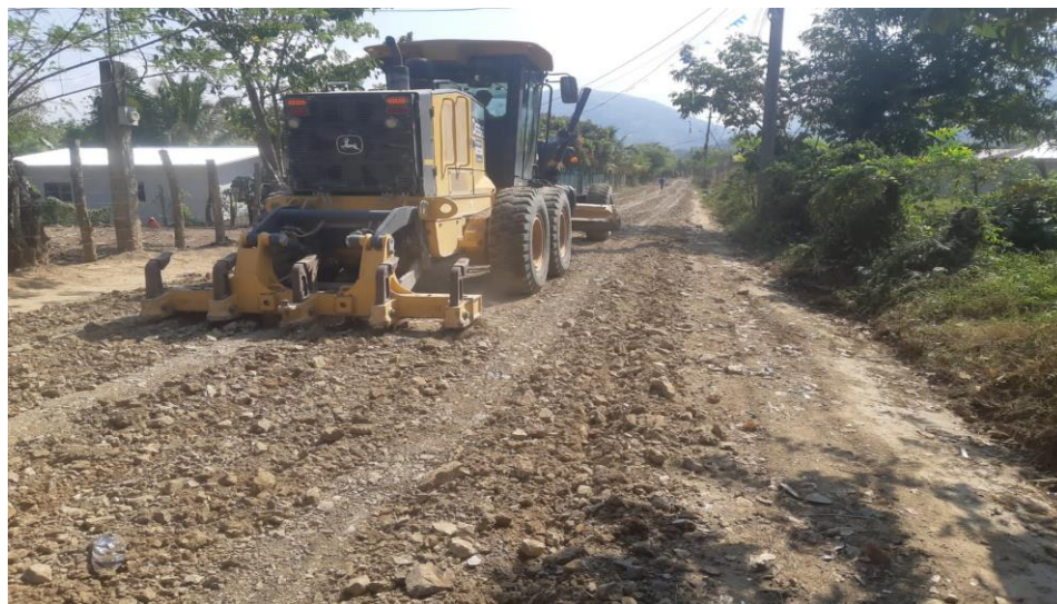
Maquinaria municipal en trabajos de escarificado, conformación cuneteo y vibrado de calle que conduce del barrio El Dorado hacia la aldea Quebrada Seca
