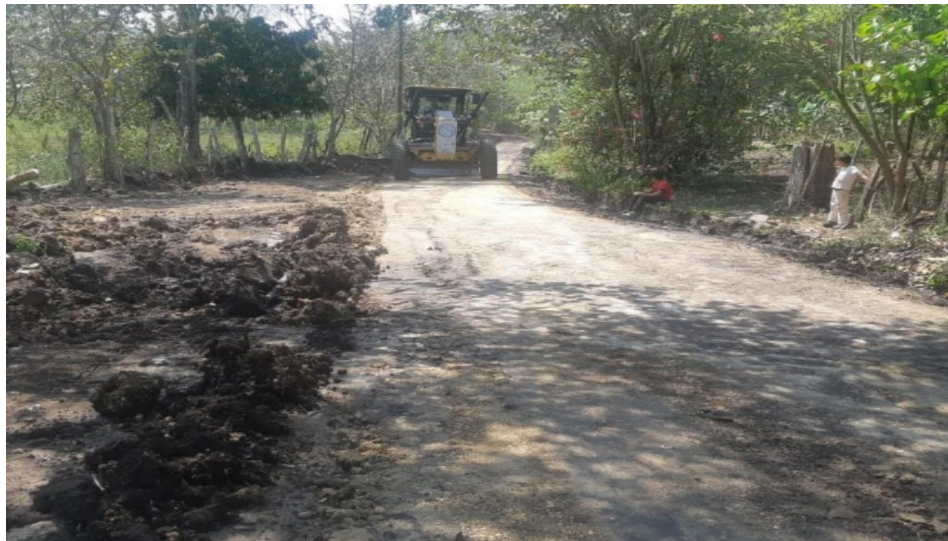
Maquinaria municipal en trabajos de escarificado, conformación cuneteo y vibrado de calle que conduce del caserío El Borbollón hacia la aldea Plan del Limón
