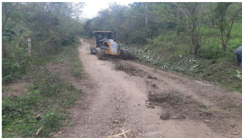
Maquinaria municipal en trabajos de escarificado, conformación cuneteo y vibrado de calle que conduce de la aldea San Pablo del Roble hacia Sector La Zona
