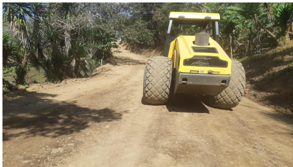
Maquinaria municipal en trabajos de escarificado, conformación cuneteo y vibrado de calle que conduce de la aldea Quebrada Seca hacia la aldea San Diego
