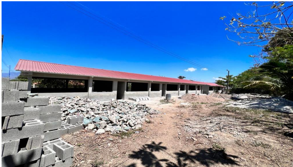
Avance de obra en el proyecto de ampliación CEB 21 de Octubre y JN Dr. Ramon Rosa
