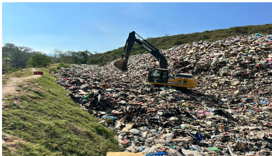
Se aprecia la maquina Excavadora 210-G en trabajos de soterramiento de basura en Relleno Sanitario
