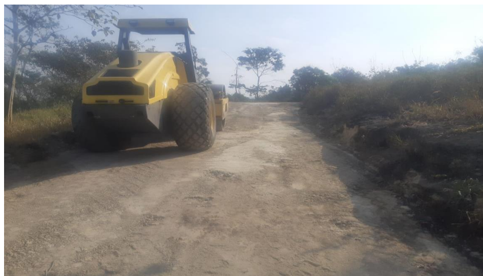
Maquinaria municipal Motoniveladora 670-G y Vibro compactador en trabajos de escarificado, conformación, cuneteo y vibrado de calles en la aldea Santa Luz
