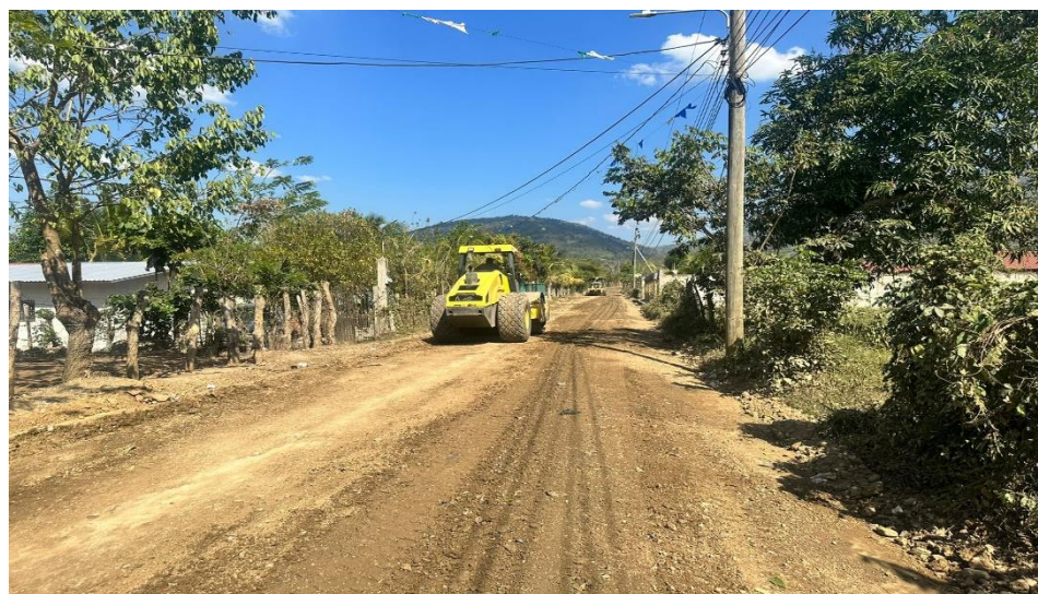
Maquinaria municipal en trabajos de escarificado, conformación cuneteo y vibrado de calle que conduce del barrio El Dorado hacia la aldea Quebrada Seca
