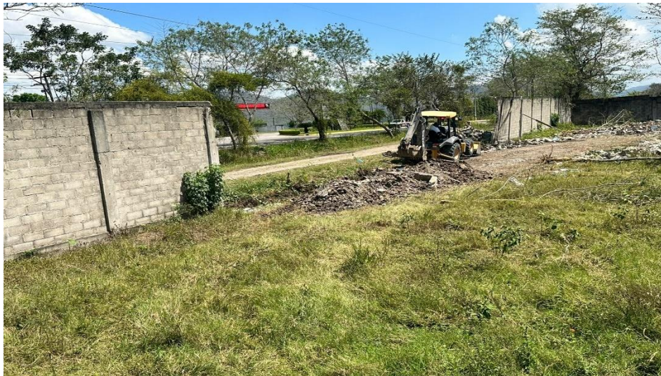
Maquina Retroexcavadora 310-L en trabajos de excavación para la reconstrucción del muro perimetral en el campo deportivo Las Alsacias
