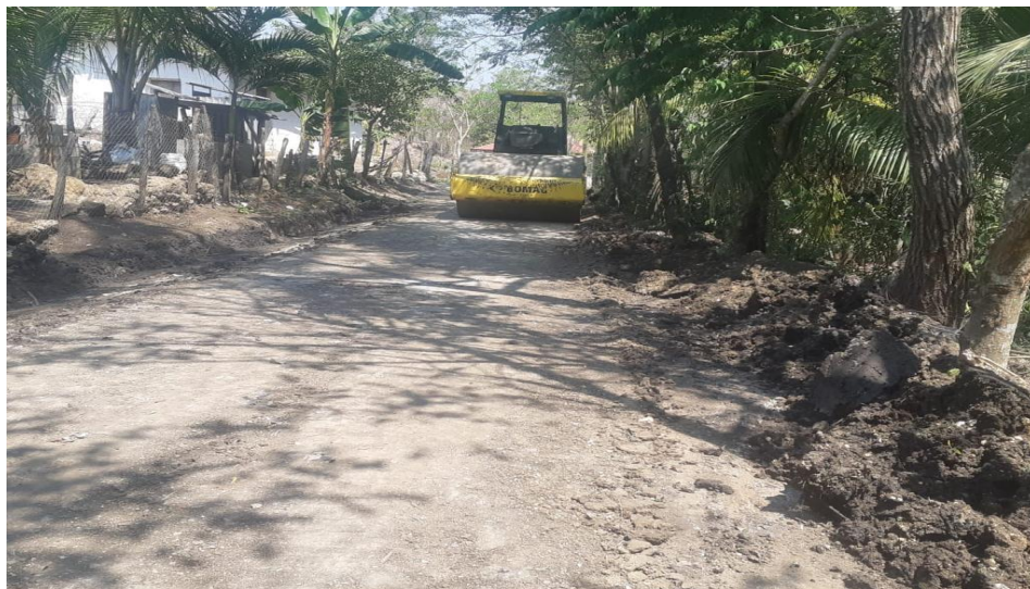
Maquinaria municipal en trabajos de escarificado, conformación cuneteo y vibrado de calle que conduce del caserío El Borbollón hacia la aldea Plan del Limón
