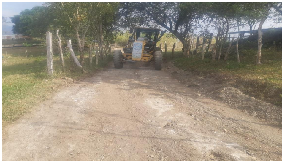
Maquinaria municipal Motoniveladora 670-G y Vibro compactador en trabajos de escarificado, conformación, cuneteo y vibrado de calles en la aldea Santa Luz
