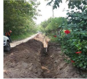
Proceso Construcción de Redes secundarias en los Cerritos de Calán, colocación de tubería de conducción hacia los tanques de abastecimiento de agua en KM6 y Calán.
