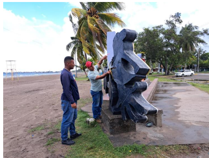
Supervisión de paradores dañados en las diferentes playas del municipio
