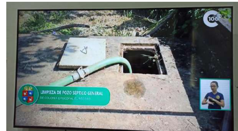
Limpieza de pozo séptico
