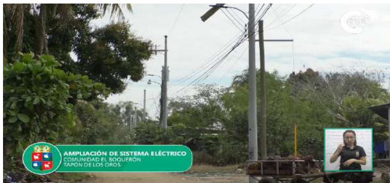
Ampliación de sistema eléctrico tapón oros
