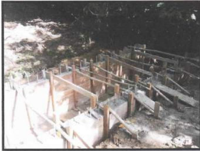
**3.5 Canal en las Lomitas, Sector Pueblo Nuevo.** Consiste en canales pluviales con paredes de bloque de concreto reforzado, piso de concreto reforzado, repellados y pulidos.
