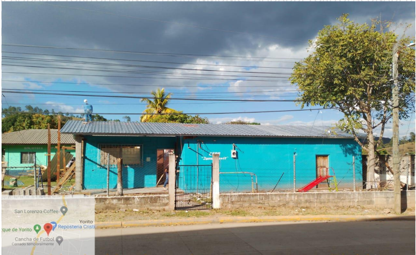
Terminación del techo del Kinder Jamil Hawit Yorito #Municipalidad de Yorito
