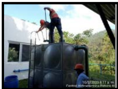
Limpieza de tanque de agua de uso doméstico 7.5 m3.
