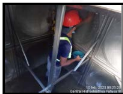
Limpieza de tanque de agua de uso doméstico 7.5 m3.
