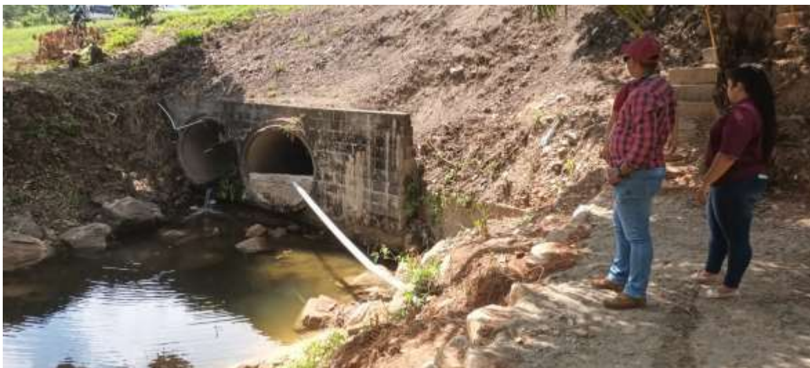
Acompañamiento al Departamento de Justicia Municipal y el Departamento de UMA en inspección de alcantarillado.
