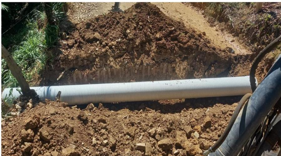
Maquina Retroexcavadora 310-L en trabajos de excavación para posteriormente instalación de alcantarilla en la aldea Cuchilla Zapa
