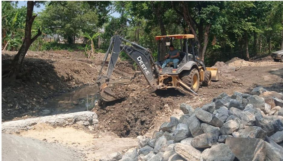
Se aprecia la máquina Excavadora 210-G y la máquina Retroexcavadora 310-L en trabajos de excavación para construcción de alas de mampostería para el proyecto construcción de vado sobre quebrada Negra, acceso a caserío El Borbollón.
