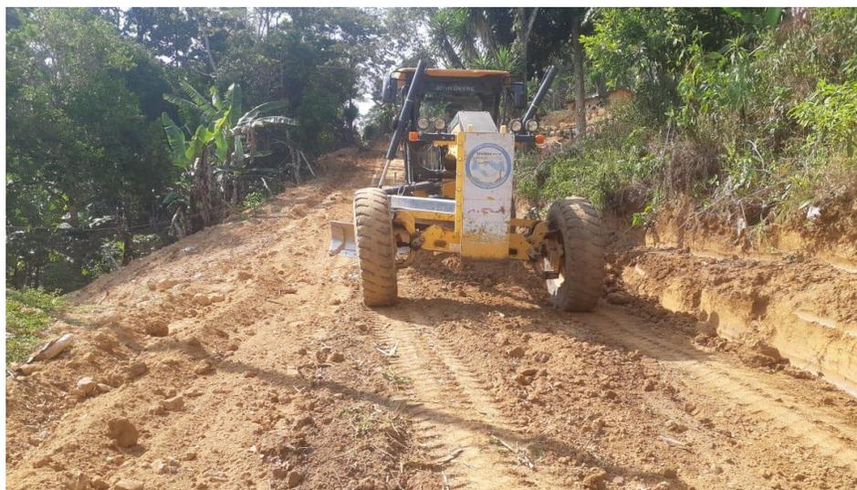
Se visualiza la maquinaria municipal en trabajos de escarificado, conformación, cuneteo y vibrado de calles en la aldea Cuchilla Zapa
