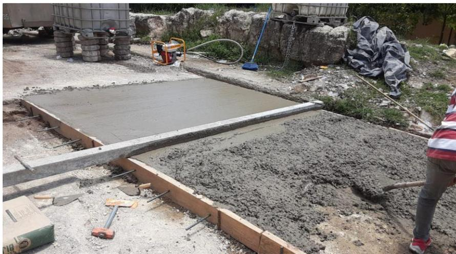
Se visualiza el personal de albañilería en proceso de fundición de losa de concreto hidráulico en el proyecto de reconstrucción de calle frente a Hermis Pineda, barrio Miraflores, La Entrada, Nueva Arcadia, Copán.
