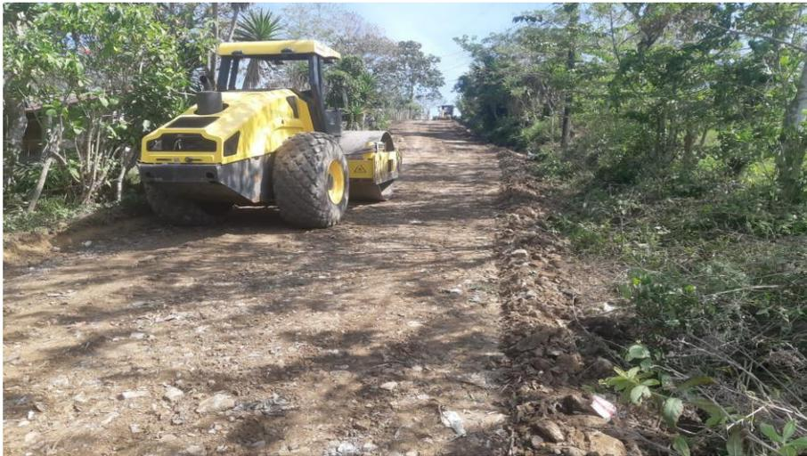
Maquina municipal Motoniveladora 670-G y vibro compactador en trabajos de escarificado, conformación, cuneteo y vibrado de calles en la aldea San Isidro
