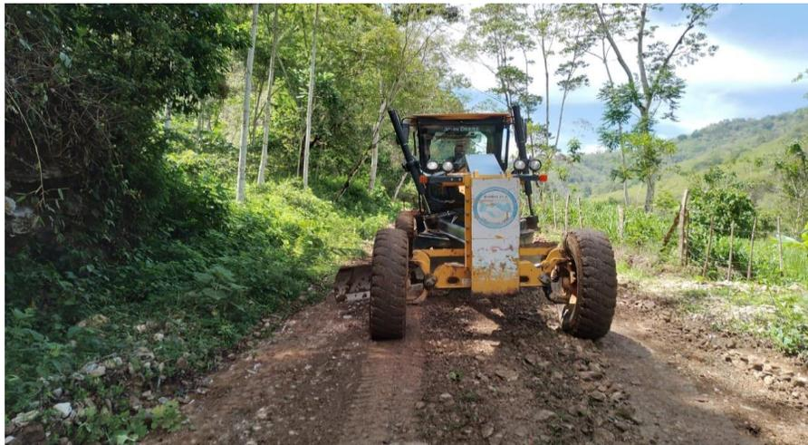
Se visualiza la maquinaria municipal en trabajos de escarificado, conformación, cuneteo y vibrado de calles en la aldea El Zanjón.
