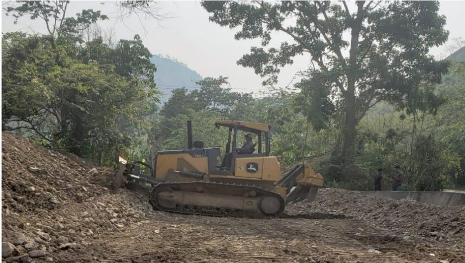
Trabajos de dragado y construcción de borda en la quebrada de la aldea El Zanjón
