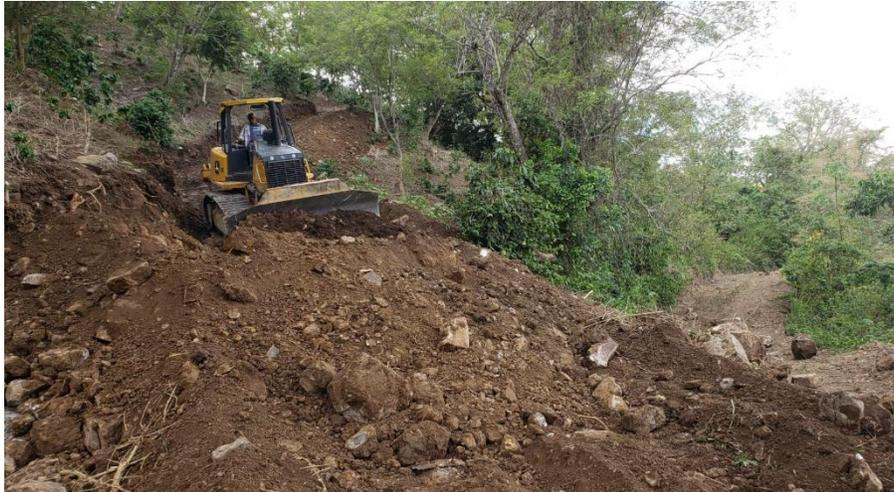
Se aprecia la máquina municipal Bulldozer sobre orugas 750J-II en trabajos de apertura y ampliación de calles en aldea Las Niguas.
