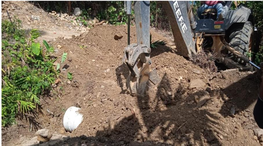
Trabajos de excavación para posteriormente instalación de alcantarillas en aldea San Isidro
