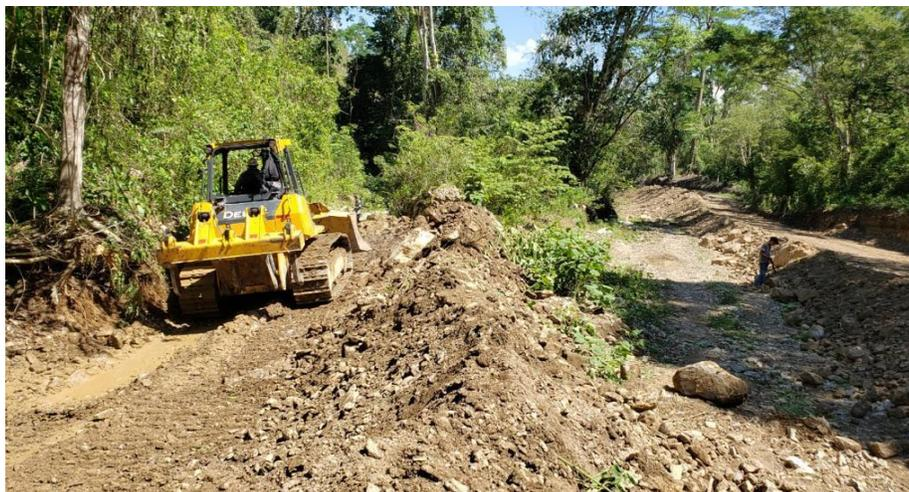
Máquina Bulldozer sobre orugas 750J-II en trabajos de dragado de quebrada en caserío Las Niguas
