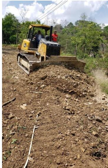
Se aprecia máquina municipal Bulldozer sobre orugas 750J-II en trabajos de apertura y ampliación de calles en la aldea Chalmeca
