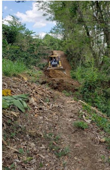
Se aprecia la máquina municipal Bulldozer sobre orugas 750J-II en trabajos de apertura y ampliación de calles en aldea Cuchilla Zapa
