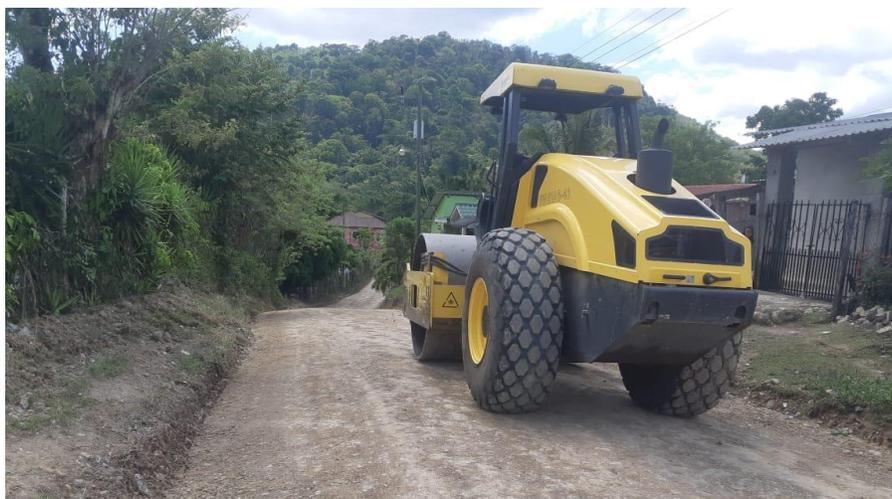
Se visualiza la maquinaria municipal en trabajos de escarificado, conformación, cuneteo y vibrado de calles en la aldea El Cedral.
