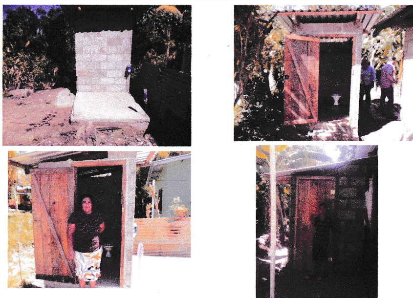
Supervisión en la Construcción de letrinas
