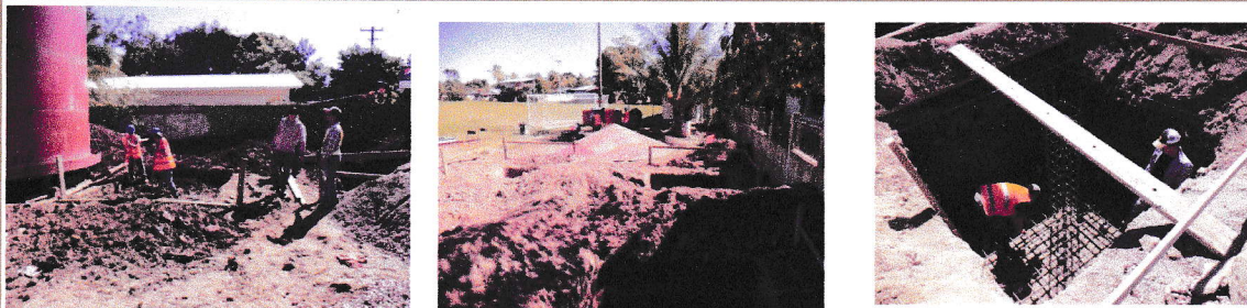
Construcción de Cimentación para colocación de tanques de Distribución.
