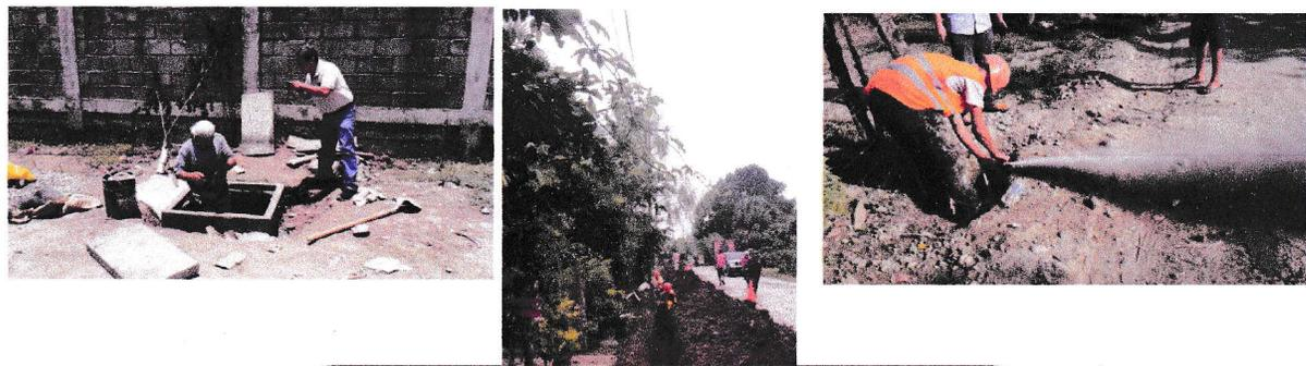
Pruebas de presión de agua y construcción de cajas para válvulas
