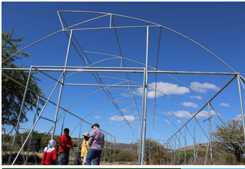
Foto 17 Construcción de Casa Malla e Invernaderos
