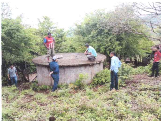
Comunidad de Santa Ana "Sistema de agua a Mejorar"
