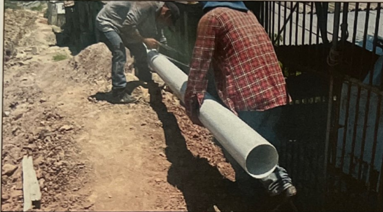
202 ML ALCANTARILLADO B° EL CALVARIO
