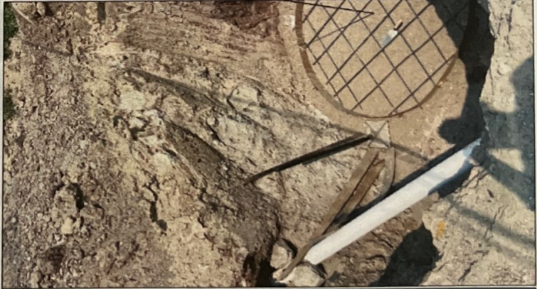
202 ML ALCANTARILLADO B° EL CALVARIO
