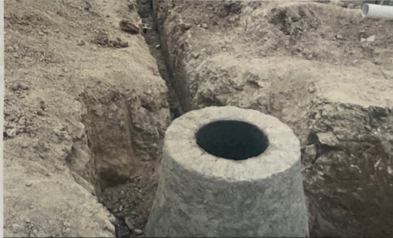
ALCANTARILLADO BARRIO EL CALVARIO
