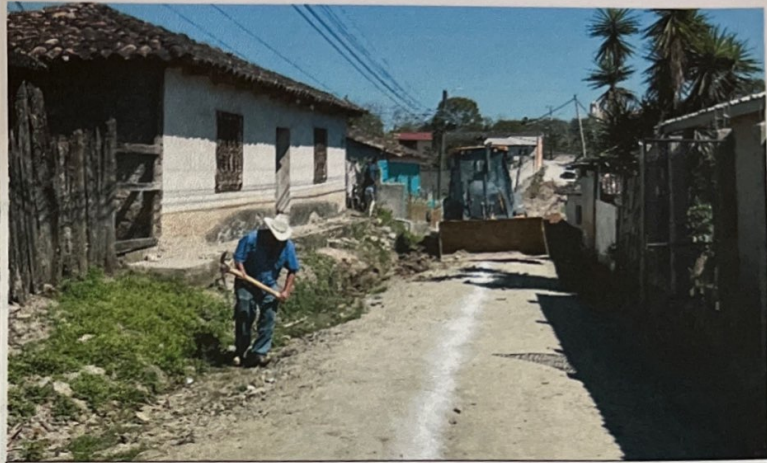
ALCANTARILLADO BARRIO EL CALVARIO
