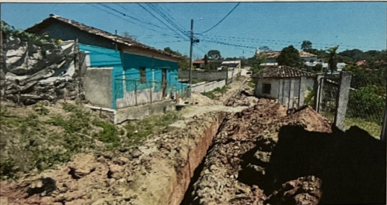
202 ML ALCANTARILLADO B° EL CALVARIO
