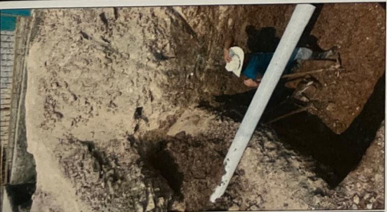
202 ML ALCANTARILLADO B° EL CALVARIO
