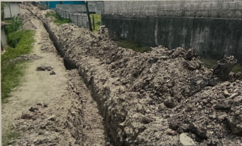
ALCANTARILLADO BARRIO EL CALVARIO
