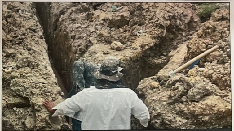
202 ML ALCANTARILLADO B° EL CALVARIO
