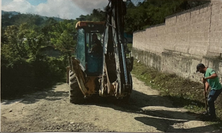
ALCANTARILLADO BARRIO EL CALVARIO
