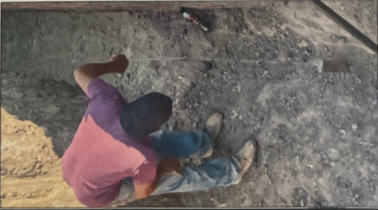
202 ML ALCANTARILLADO B° EL CALVARIO
