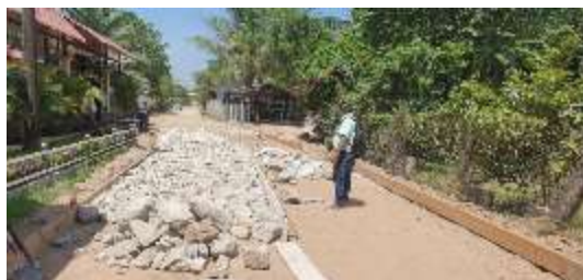
Inspección en la construcción de empedrado de calle principal de Guanacastales, Sector Ramal de Lima.
