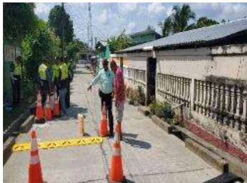
Apoyo al Depto. de Vialidad y Transporte en la instalación de túmulos en El Triunfo, Sector Puente Alto.
