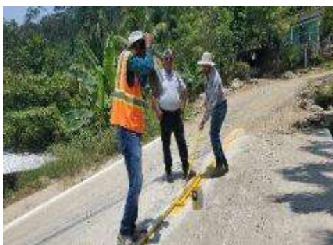
Apoyo al Depto. de Obras Menores en el pintado de calle pavimentada de Nisperales Sector Puente Alto.
