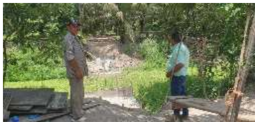
Inspección de avances de construcción de puente para paso vehicular de Kele-kele, Sector Ramal de Lima.
