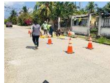
Apoyo al Depto. de Vialidad y Transporte en la instalación de reductores de velocidad en Col. El Mirador, Sector Pueblo Nuevo.
