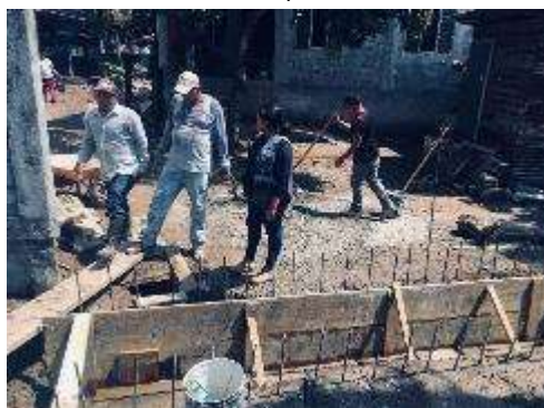
Inspección en la elaboración de canal pluvial con losa para entrada de callejón de Col. San Antonio, Sector Pueblo Nuevo.
