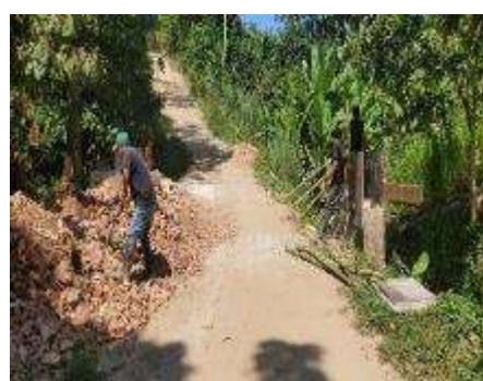
Inspección del proyecto construcción de cabezales de Caserío Morazán, Sector Puente Alto.
