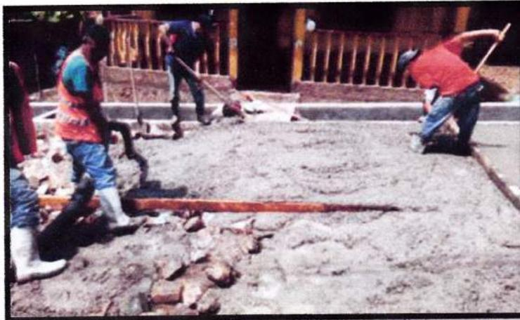
**3.5 Cabezales en San Juan Zapadril, Sector Zapadril:** Consiste en la demolición de cabezales existentes en mal estado, construcción de nuevos cabezales de mampostería a ambos lados de la calle, construcción de un muro de contención con mampostería a un costado de la calle y un cruce de calle con concreto fundido al otro costado de la calle, con un monto total de Lps.379,087.64 y un avance de ejecución del 10% con un Monto Invertido de Lps.37,908.76
