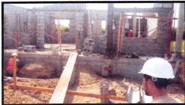
**3.10 Construcción de Centro Social (Priorizado), Colonia Episcopal El Record, Sector El Chile:** Consiste en la construcción de un salón de 8m de ancho por 10m de largo, con sobreelevación con bloque de concreto fundido, paredes de bloque de concreto e 6" sisado y lechado, dos baños, gradas de acceso, rampa de acceso para personas con discapacidad, techo de estructura metálica y lamina de aluzinc. Dicho proyecto tiene un monto final de Lps.618,729.65
