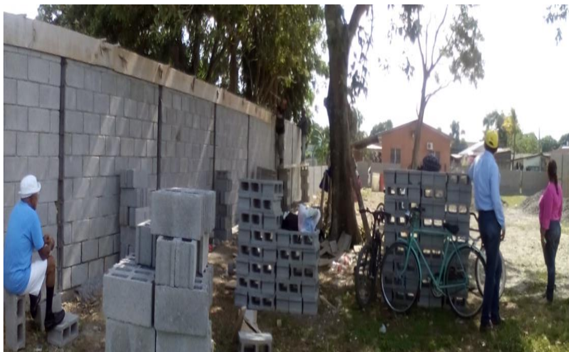
9 Supervision Cerco Perimetral I Etapa/I.H.S.S.
