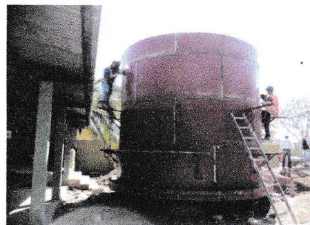
Construcción de Tanques de distribución de agua en Calán y Kilómetro Seis
