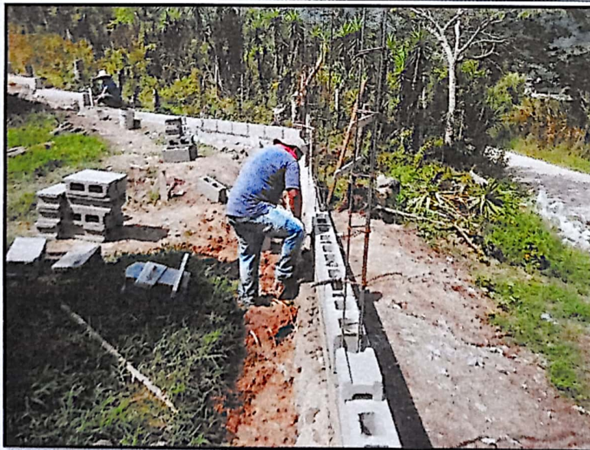
7 Colocando primera hilada de bloque en la parte de abajo del CEB
