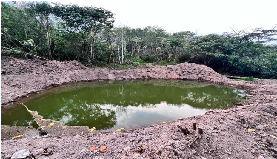
Trabajos de excavación la cual funciona como represa para almacenamiento de agua para las comunidades de El Chile, La Cuchilla Zapa y San Isidro.
