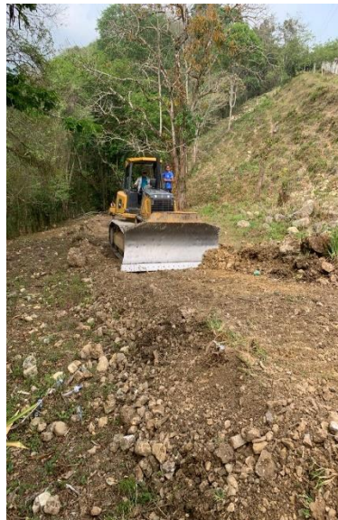
Maquina bulldozer sobre orugas 750J-II en trabajos de apertura y ampliación de calles en la aldea El Cedral
