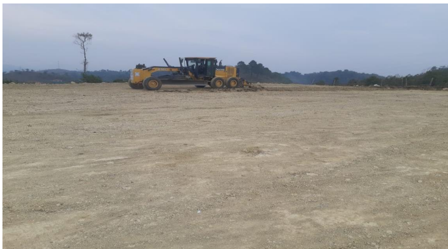
Maquina Motoniveladora 670-G y Vibro compactador en trabajos de conformación y vibrado de campo en la aldea Tres Cruces
