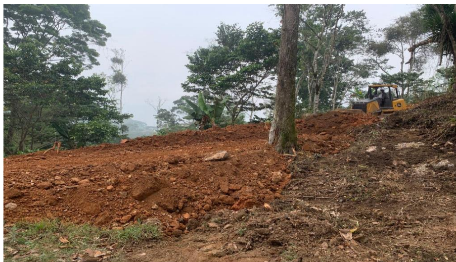
Maquina municipal en trabajos de apertura y ampliación de calles en la aldea Las Conchas.
