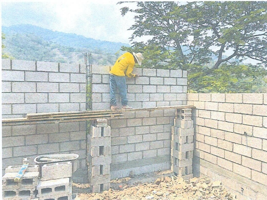
CONSTRUCCION DE LA ESCUELA CARLOS ANDULFO EN LA COMUNIDAD DE LOS LAURELES AGUANQUETERIQUE LA PAZ.
