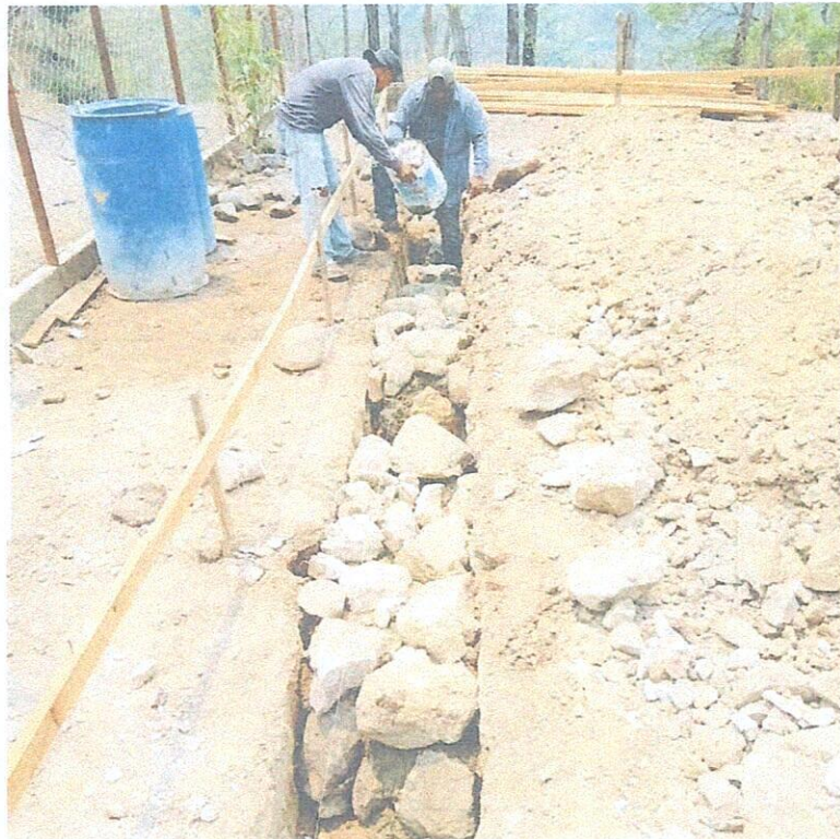
CONSTRUCCION DE LA ESCUELA CARLOS ANDULFO EN LA COMUNIDAD DE LOS LAURELES AGUANQUETERIQUE LA PAZ.
