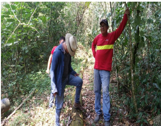
Traslado de Tubería AMPAC
