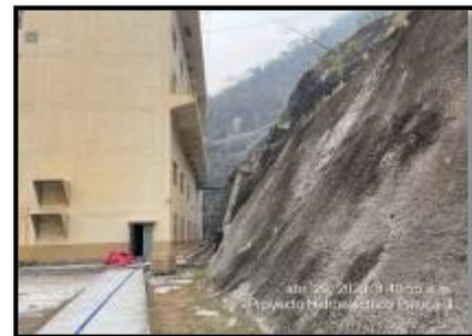
**Anclajes pasivos y activos aguas arriba de Casa de Máquinas; no se detectaron agrietamientos.**
