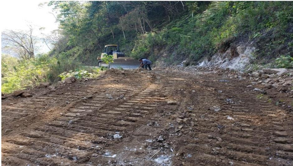
Maquina Bulldozer sobre orugas 750J-II en trabajos de ampliación y limpieza de calle que conduce de la aldea Quebrada Seca hacia la aldea Cuchilla Zapa
