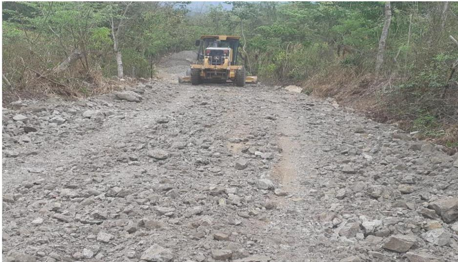
Se visualiza la máquina municipal Motoniveladora 670-G y Vibro compactador en trabajos de escarificado, conformación, cuneteo y vibrado de calles en la aldea Plan del Limón
