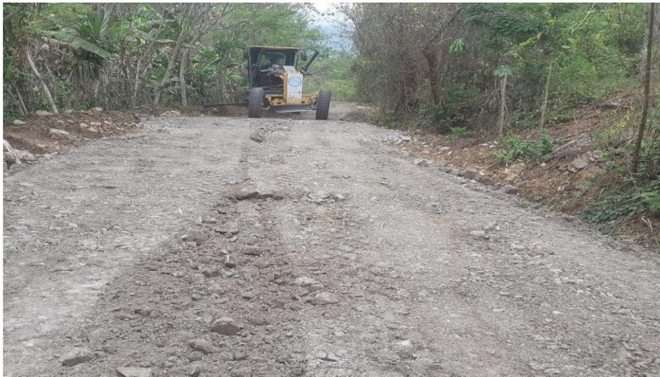
Trabajos de escarificado, conformación, cuneteo y vibrado de calle que conduce de la aldea Plan del Limón hacia caserío El Borbollón
