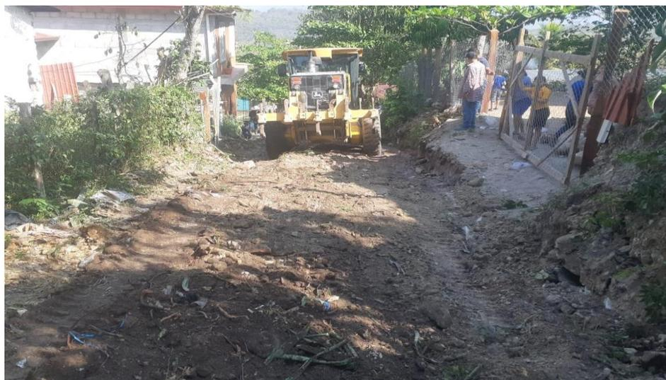
Se visualiza la máquina municipal Motoniveladora 670-G y Vibro compactador en trabajos de escarificado, conformación, cuneteo y vibrado de calles en la aldea San Pablo del Roble
