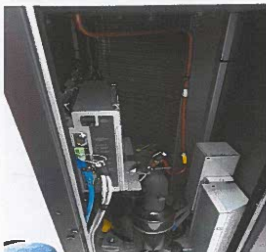
mantenimiento preventivo realizado.
