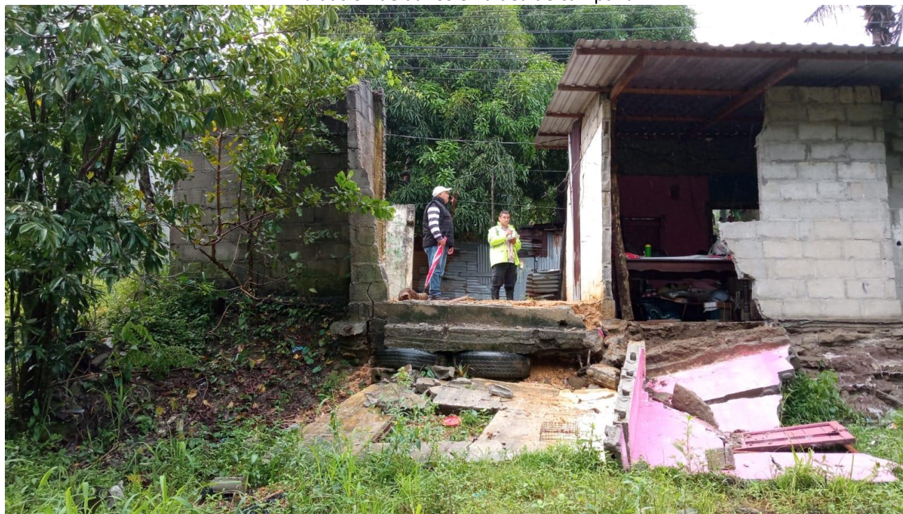
Evaluación de daños en aldea de campana
